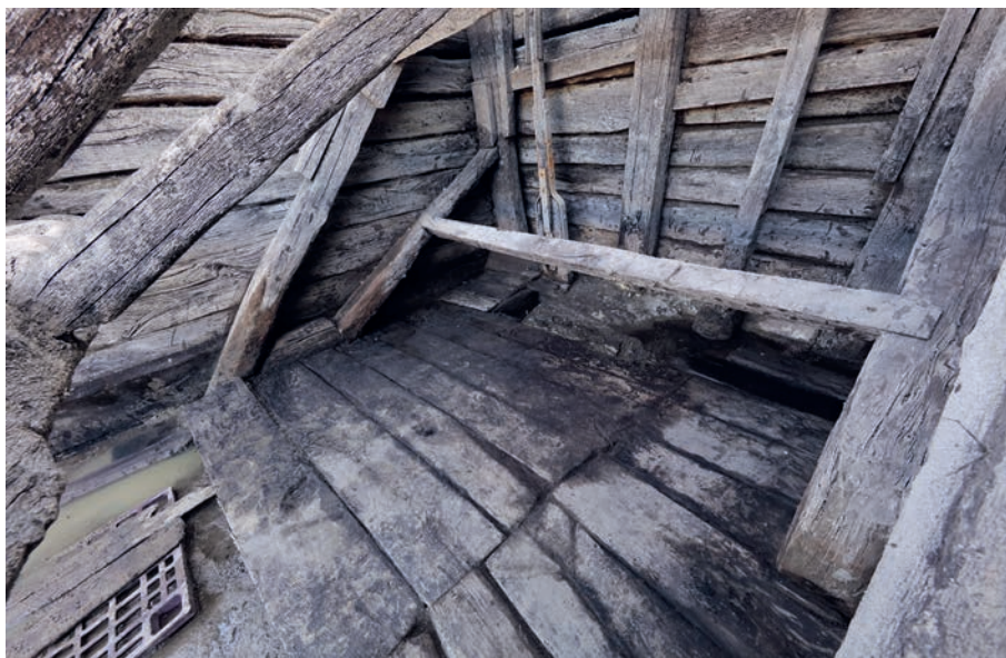
Figure 17 : Portique - Sol - Vue depuis le NORD-EST (cliché O. Veissière).
