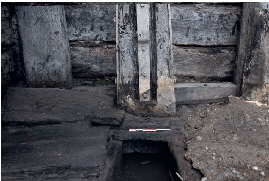
Figure 23 : Portique - Contrecœur - Vanne à guillotine ou à pelle - Vue depuis l'EST.
