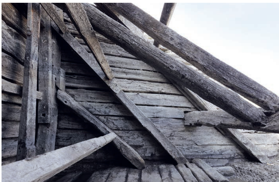
Figure 18 : Portique - Épaulier NORD - Vue depuis le SUD (cliché O. Veissière).
