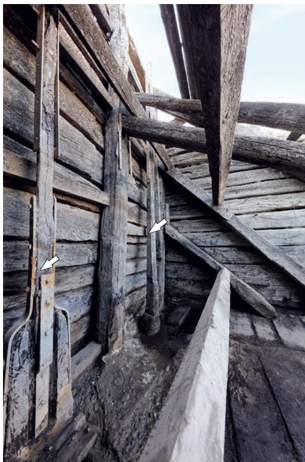
Figure 5 : Grande bonde - Portique - Contrecœurs avec système de pilon - Vue du SUD.
