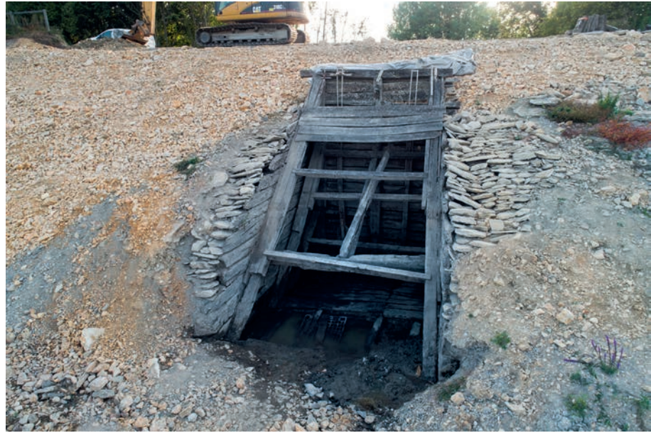
Figure 2 : Grande bonde - Portique visible après l'assèchement de l'étang - Vue de l'EST (cliché O. Veissière).
