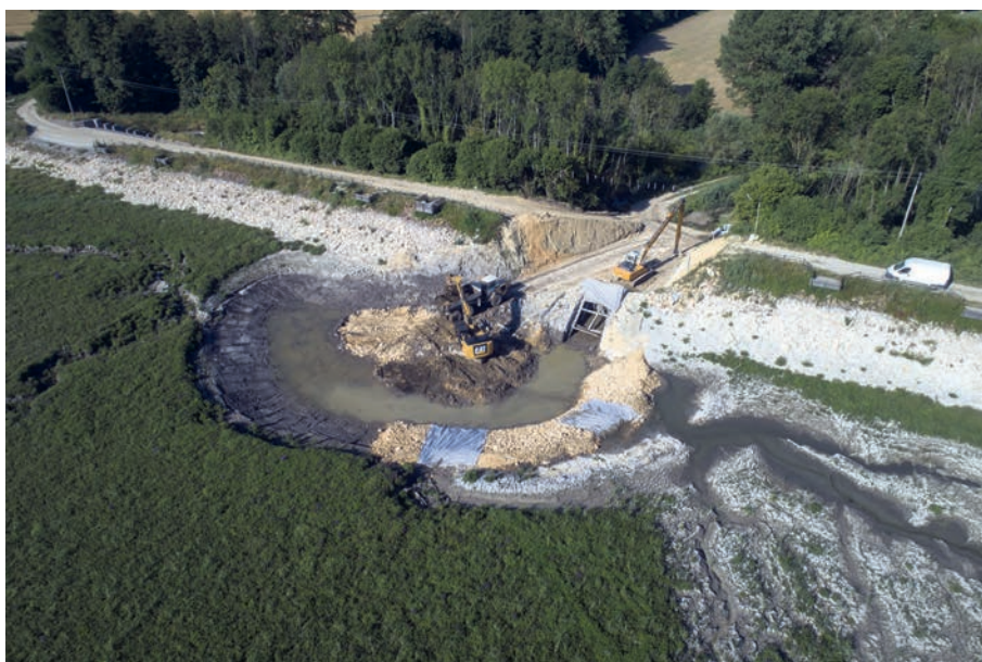
Figure 1 : Grande bonde pendant les travaux - Étang asséché - Vue aérienne depuis l'EST (cliché O. Veissière).
