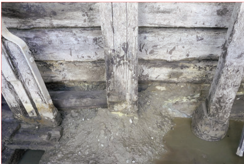
Photo 3 (en haut) : Vue des 2 systèmes d'obturation des auges. A gauche, à pelle et à droite, à pilon.
