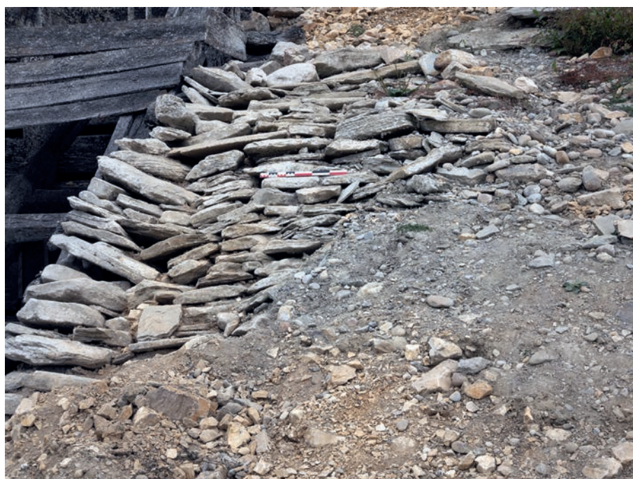
Figure 14 : Grande bonde - Enrochement du portique.
