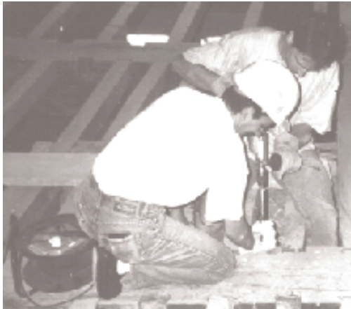
Photo 1 (Lavier) : Prélèvement à la tarière électrique
