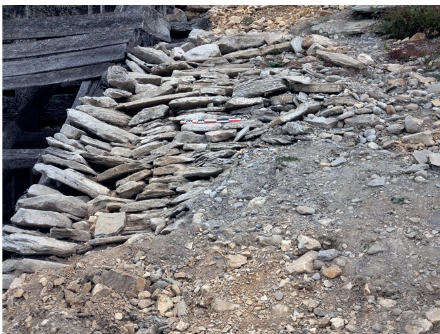
Figure 14 : Grande bonde - Enrochement du portique.
