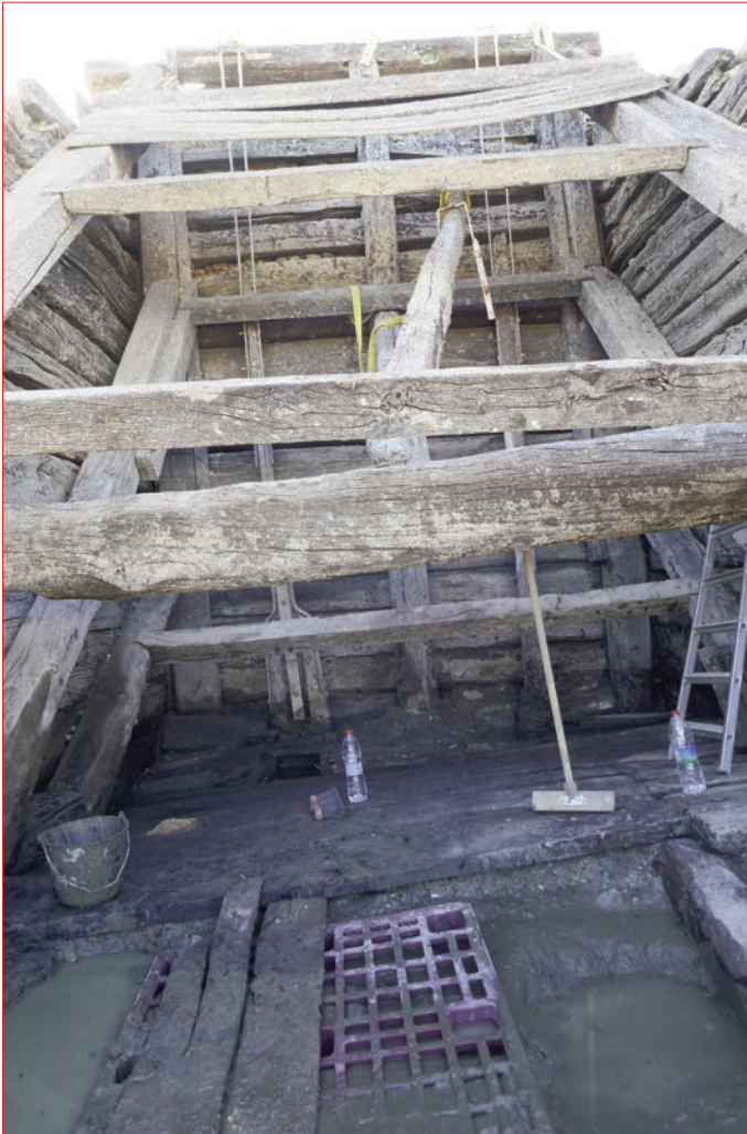
Photo 2 : Vue de la chambre de bondage, après vidange de l'étang.
