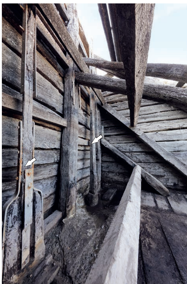
Figure 5 : Grande bonde - Portique - Contrecœurs avec système de pignon - Vue du SUD.
