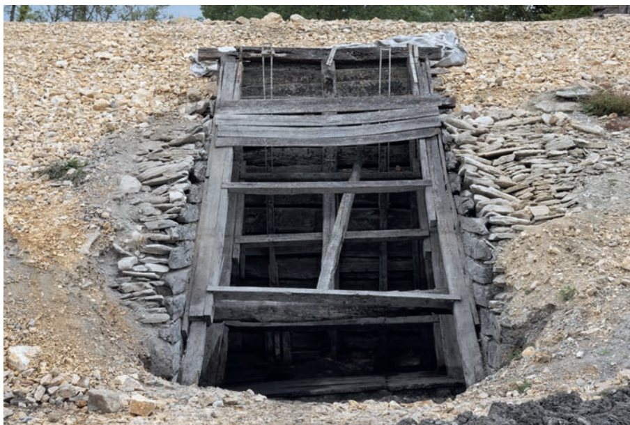
Figure 4 : Grande bonde - Portique visible lors de l'assèchement de l'étang - Vue de l'EST.
