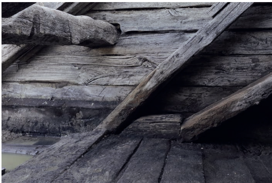
Figure 20 : Portique - Épaulier sud - Jambes de force retenue par un sabot - Vue depuis le NORD.
