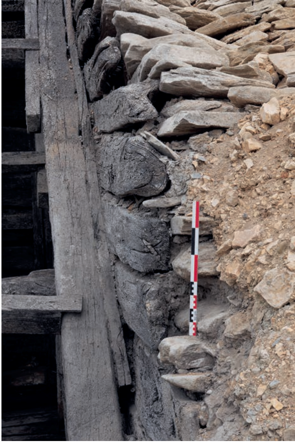
Figure 15 : Grande bonde - Blocs de pierre (grès molassique agencés autour de l'épaulier NORD.
