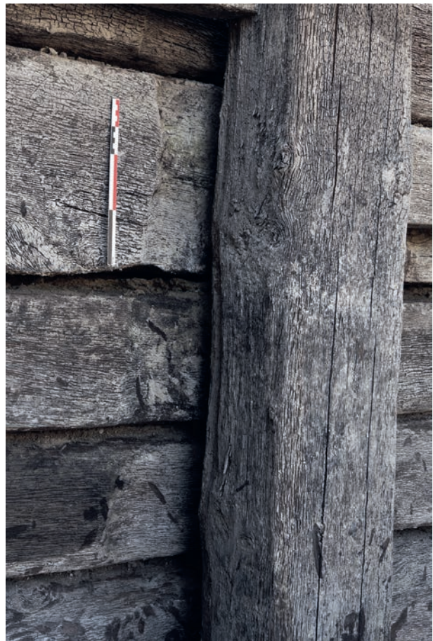
Figure 19 : Portique - Contrecœur - Creusement au droit du poteau central - Vue depuis l'EST.
