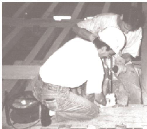
Photo 1 (Lavier) : Prélèvement à la tarière électrique
