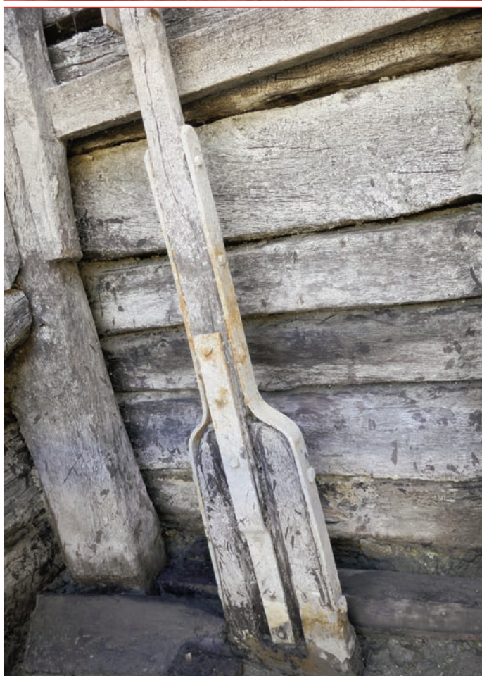
Photo 3 (en haut) : Vue des 2 systèmes d'obturation des auges. A gauche, à pelle et à droite, à pilon.
