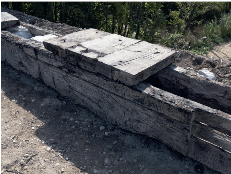
Figure 28 : Auge et couvercle - Essai d'assemblage des deux éléments de la conche.
