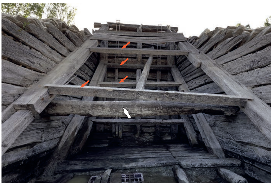
Figure 21 : Portique - Entretoises disposées entre les deux épauliers par l'intermédiaire des jambes de force - Vue depuis l'EST.
