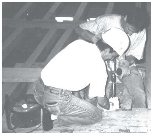
Photo 1 (Lavier) : Prélèvement à la tarière électrique
