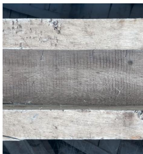
**Fig. 29. Tour Dauphine**, plancher, ais d'entrevous, sciage mécanique.
