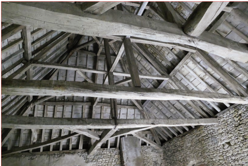
Photo 1 (en haut) : Vue de la charpente de la maison Graven - ferme F9 face est. Cliché E. Bouticourt. Photo 2 (en bas) : Vue de la charpente de la tour dauphine, vers l'ouest.
