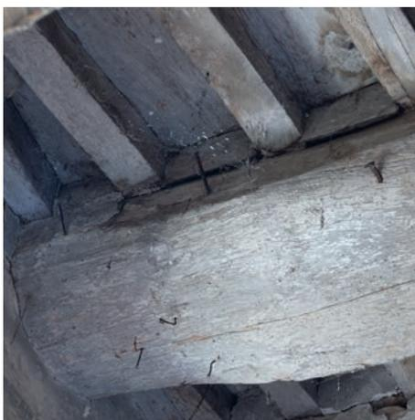
**Fig. 26.** Tour Dauphine, poutre 2, extrémité flacheuse.
