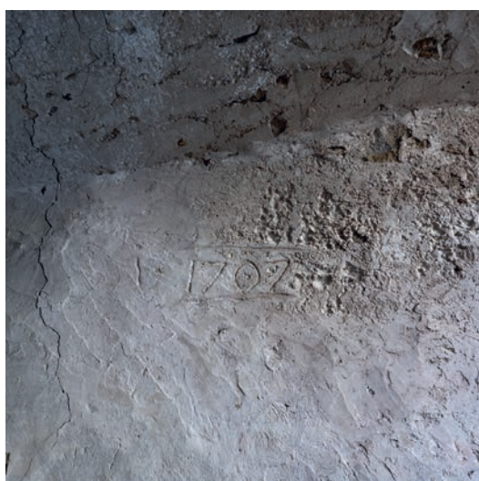
Fig. 10. Maison Graven, mur nord, porte d'accès aux caves, embrasure, millésime 1707.
