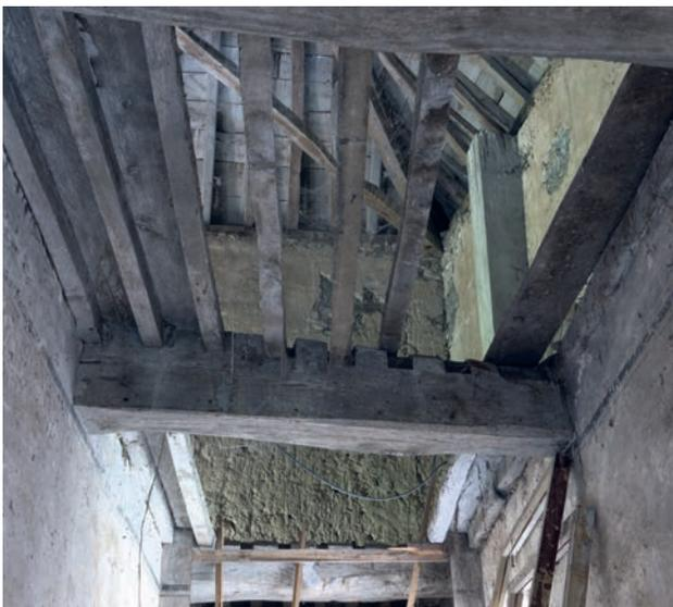
Fig. 3. Tour Dauphine, structure de plancher partiellement détruite, vue de l'est.
