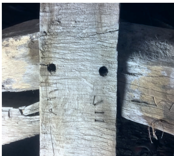
Fig. 28. Maison Graven , ferme 5, trace de sciage manuel.
