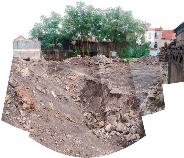
PANORAMA DU BOSQUET D'AILANTHES DANS LE CHANTIER, SUITES AUX PREMIÈRES DÉMOLITIONS. [© TIBO LABAT 014/HOAC]
