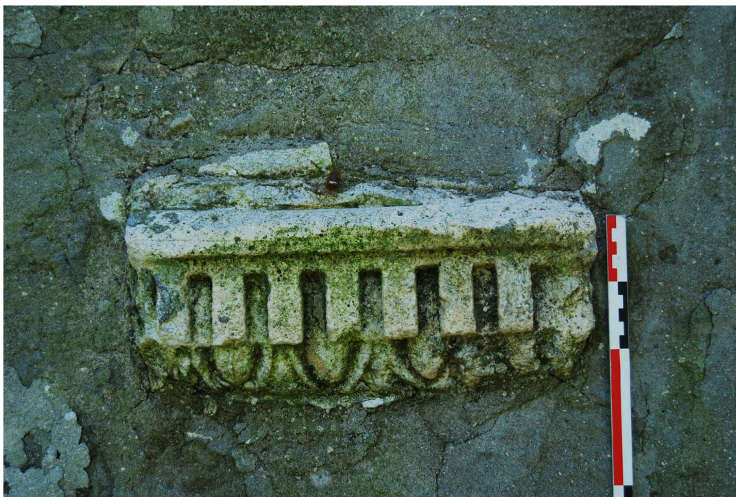
Fig. 3. Fragment de corniche ionique de la période hellénistique ou romaine remployé dans les murs de l'église de Saint-Nicolas à Frakull e Madhe
