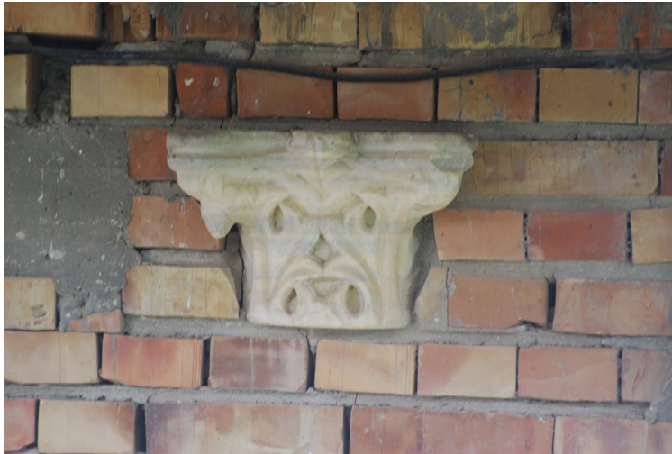
Fig. 16. Chapiteau remployé dans une maison du village d'Armen
