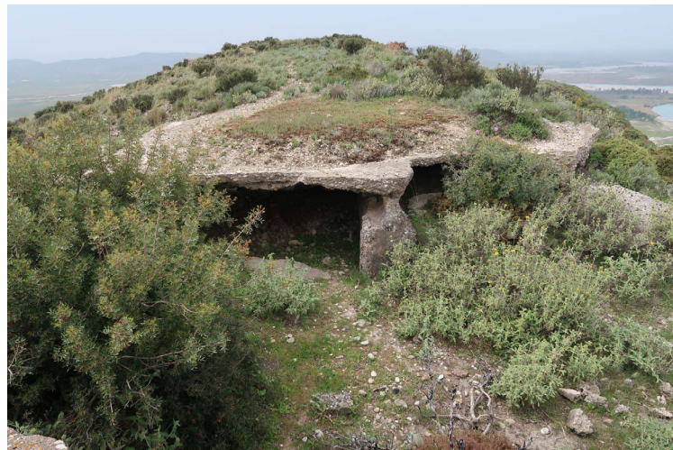
Fig. 17. Restes d'installations militaires de l'année 1920 construites par l'armée italienne à Armen
