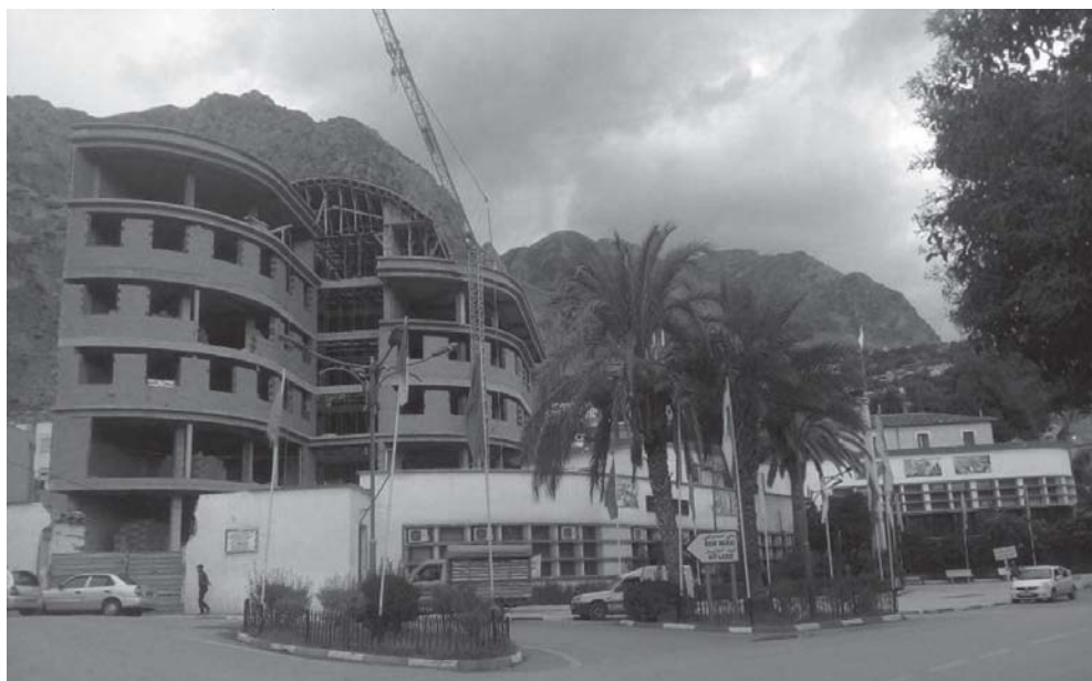
Figure 5 : vue de l'hôtel de ville avec la nouvelle mairie en construction.
