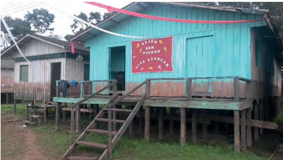
Figura 2: Casa comunitária da Vila Alencar, na parede fica visível o nível alcançado pela água em 2015.
