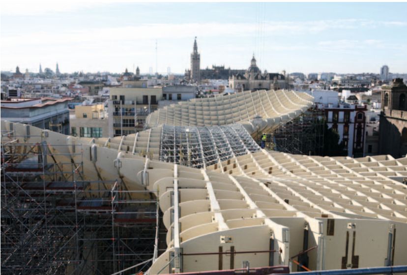
Fig. 15. Continuité topologique démontré par le tore généralisé à deux trous Fig. 16.1, 16.2, 16.3. Vue du chantier, Metropol Parasol, Plaza de la Encarnación, Séville (Espagne)
