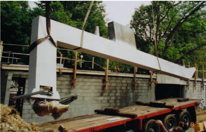
2-3. R. Koolhaas/OMA, maison Lemoine, Floirac, près de Bordeaux, 1994-1998, en collaboration avec Ove Arup. Élément porteur lors de l'assemblage
