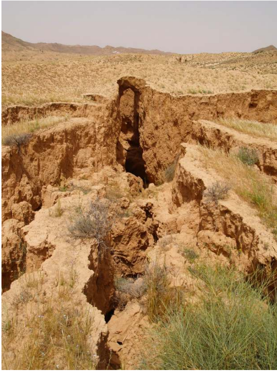
Figure 16. Suffosion dans la tabia distale de la ravine BDh. Noter que la tabia est encore partiellement en place. L'incision a une hauteur d'environ 6 mètres
