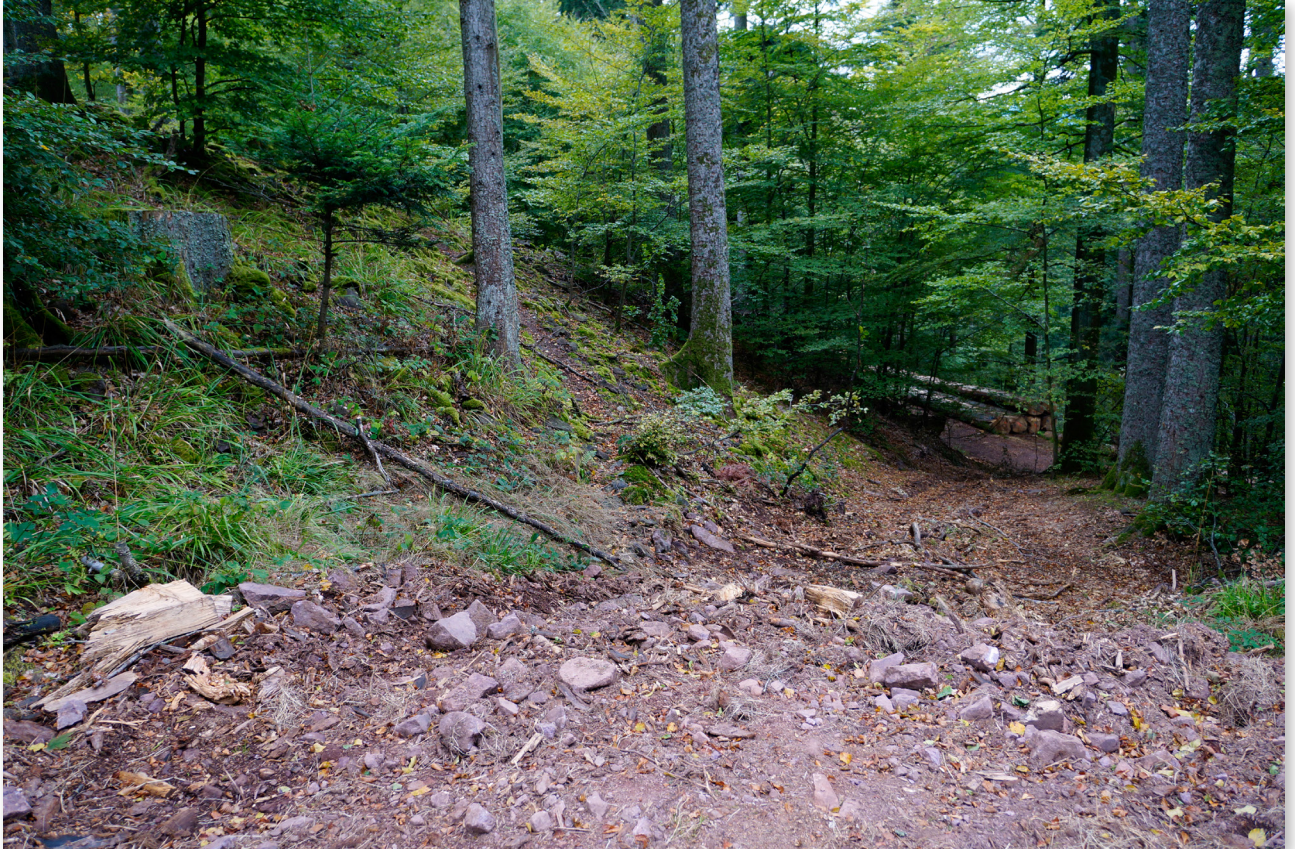
Figure 37 (ci-dessus) : Dégradations du fossé du rempart n°2 liées aux récents travaux forestiers, vue vers l'est (Cliché S. Gentner)
