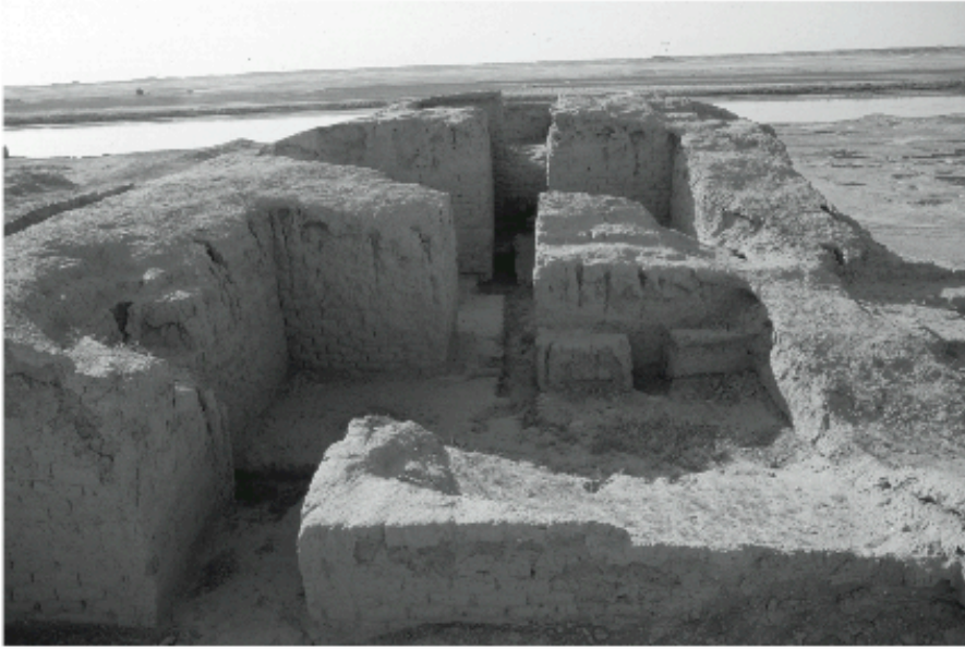
Fig. 5. La citadelle vue depuis le sud-est. On distingue au fond les marches desservant, à l'origine, l'étage (cliché C. Kepinski).
