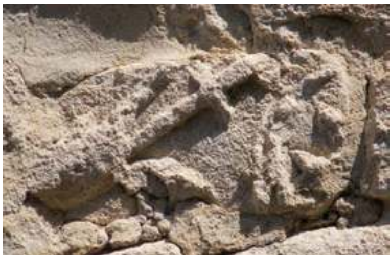
Fig. 20a-d - Réemplois divers dans les élévations extérieures de la cathédrale Notre-Dame-de-Nazareth conservés dans leur forme initiale ou retailés en moellons (C. Lefebvre).
