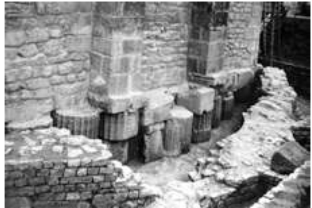
Fig. 14 - La fondation du massif du chevet de la cathédrale Notre-Dame-de-Nazareth prise à la suite de son dégagement en 1949 par le chanoine J. Sautel (fonds J. Sautel, Service du Patrimoine de Vaison-la-Romaine).
