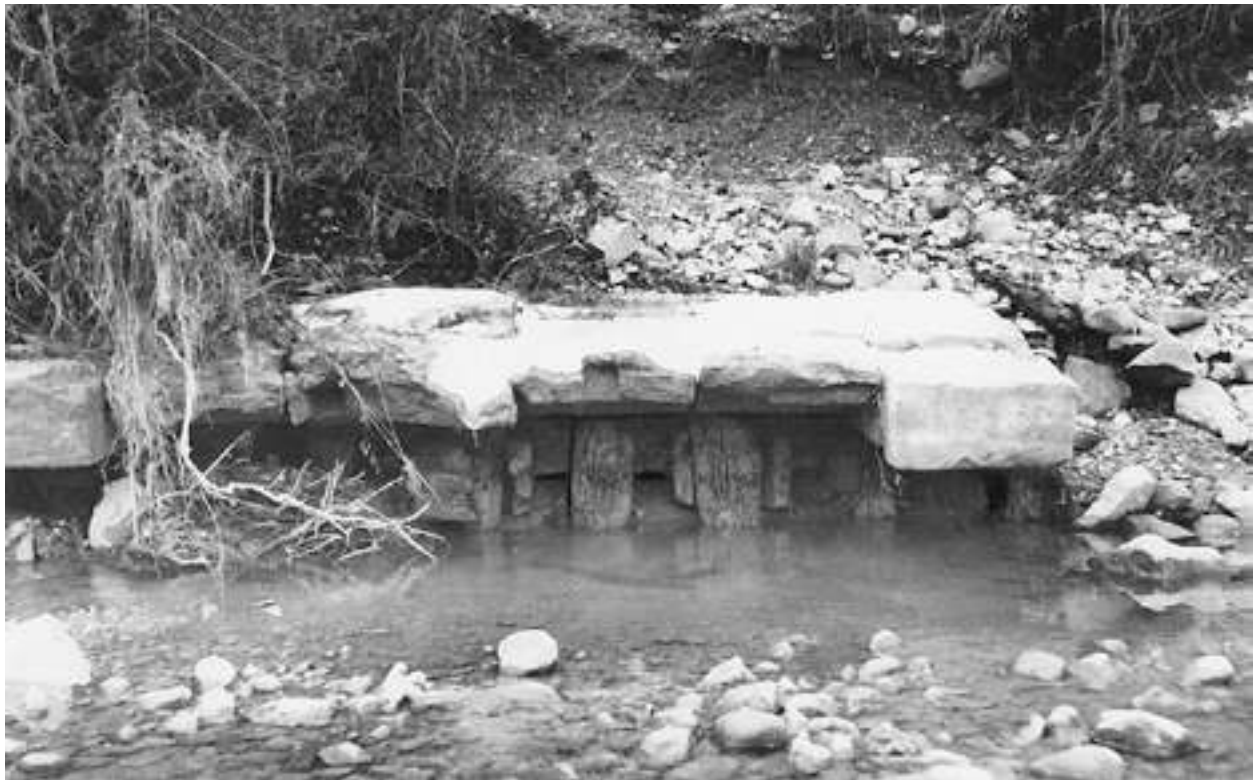
Fig. 3 - Vestiges des fondations sur pilotis de la rive gauche de l'Ouvéze en 1947 (fonds J. Sautel, Service du Patrimoine de Vaison-la-Romaine).
