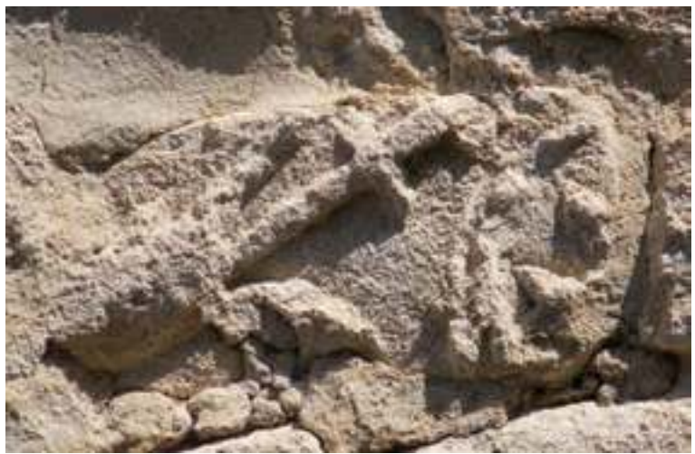
Fig. 20a-d - Réemplois divers dans les élévations extérieures de la cathédrale Notre-Dame-de-Nazareth conservés dans leur forme initiale ou retailés en moellons (C. Lefebvre).
