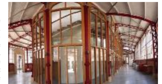
Fig. 6- Occupation « réversible » du volume intérieur de la halle des Douves par un volume nouveau (© Ch. Callais)
