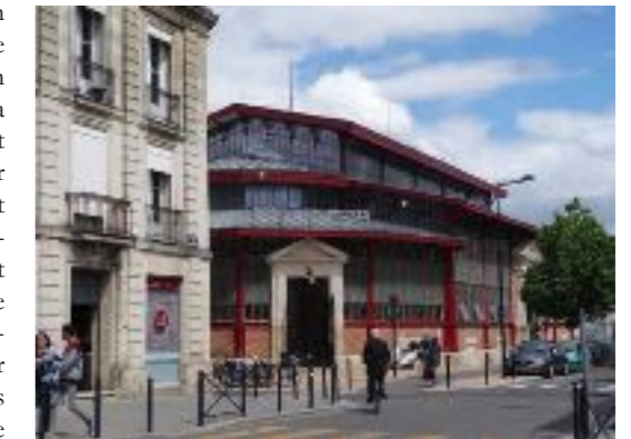
Fig. 4- La halle du marché des Douves rénovée (© Ch. Callais)
