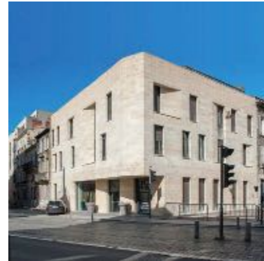
Fig. 3 - MDSI (Moon Safari architectes). Si ce bâtiment est en pierre, il assume sa mise en œuvre en parement (© L. Stoffel)
