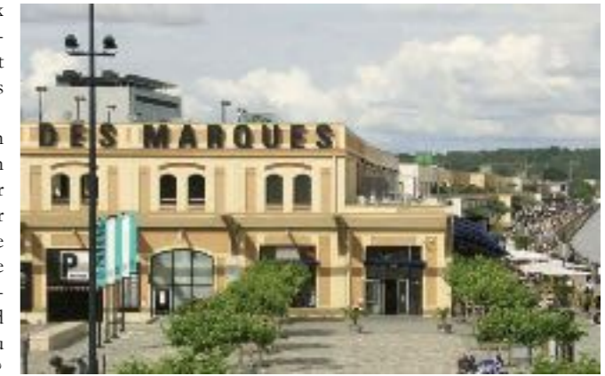
Fig. 10- Une coloration fondée sur un dégradé de couleurs inspirées de celles de la pierre (© Ch. Callais)
