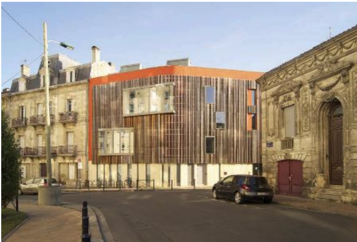
Fig. 13- L'extension du Conservatoire de Bordeaux est un bâtiment public à l'échelle domestique (© P. Saillant).
