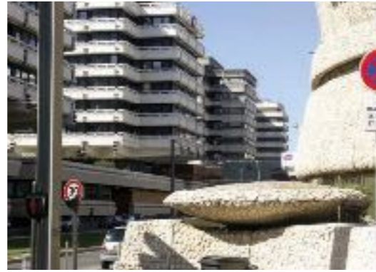
Fig. 2 - Les tours en croix en face de la Caisse d'épargne (© Ch. Callais)
