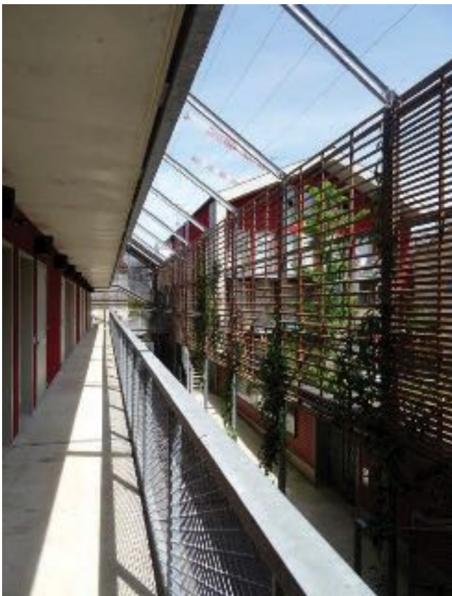
Fig. 14- Vue de l'intérieur de l'opération (© M. Dando)
