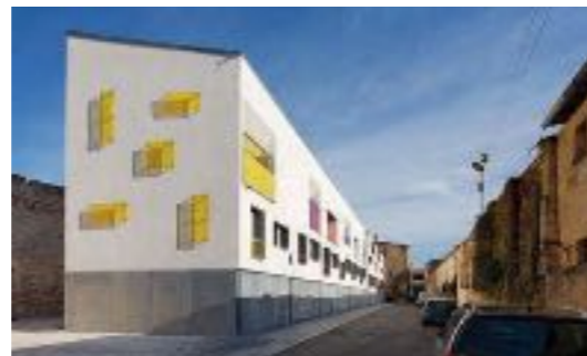
Fig. 6- Les logements rue de Surson, lumineux et surprenant dans leur contexte (© agence B. Bühlher)
