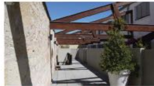
Fig. 9- En créant une façade en retrait de la façade originale, Leclercq crée des espaces extérieurs pour les logements jouant avec l'esthétique des anciennes fermes en bois (© Ch. Monney).
