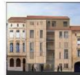
11.21. 43 rue Carpentier © PC société de Bordeaux
