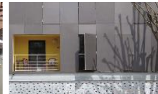
Fig. 8- Les volets mobiles du Stadion par un jeu modulé la façade au cours de la journée (©A. Bousignes)
