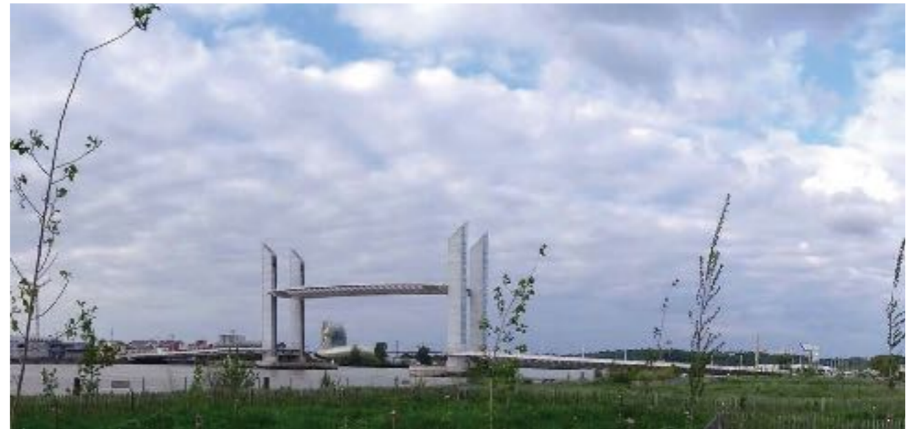
Fig. 1 - Le pont Chaban-Delmas (Lavigne et Chéron architectes), désormais porte du Port de la Lune depuis l'Océan (© Ch. Callais)
