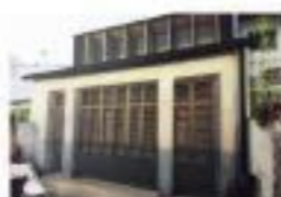
8.4, 12 rue de Tolome © PC mairie de Bordeaux
