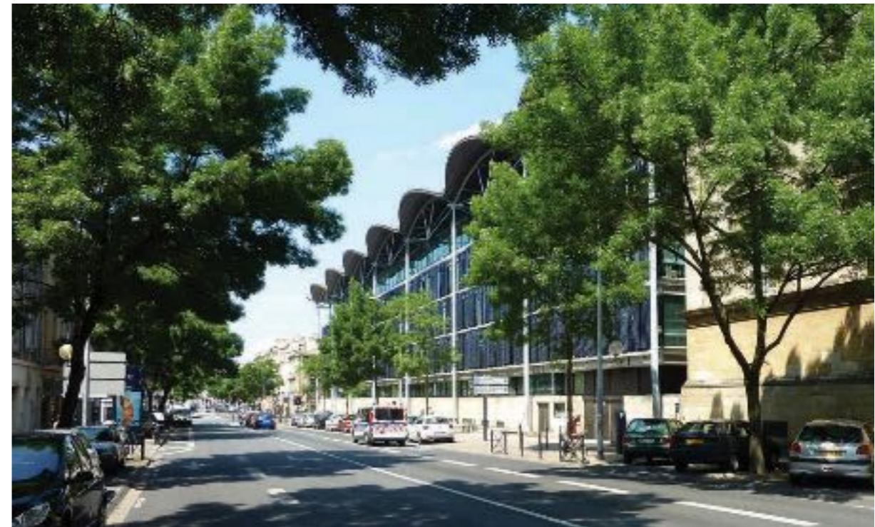
Fig. 11- Tribunal de grande instance de Richard Rogers. L'édifice n'a sans doute pas besoin de voir justifier sa mise en forme par une référence à une colonnade classique (© Ch. Callais)
