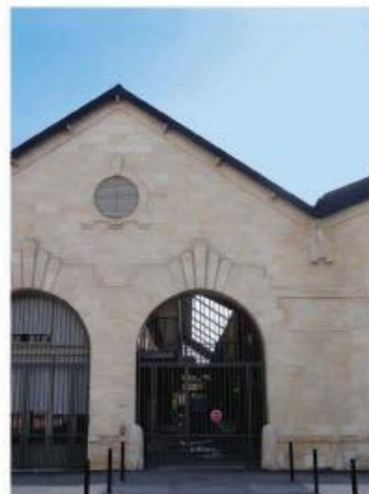
Fig. 5 - Oranger ses toitures côté pour lui redonner vie : des chais reconvertis en logements par Canal Architecture (© M. Dando)
