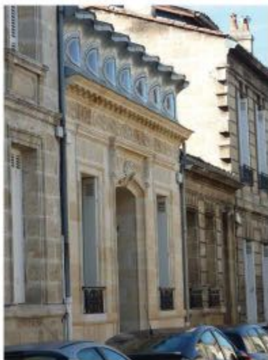
Fig. 2 - Savants ventilation d'une façade par Bertrand Nivelle (© Ch. Collas)
