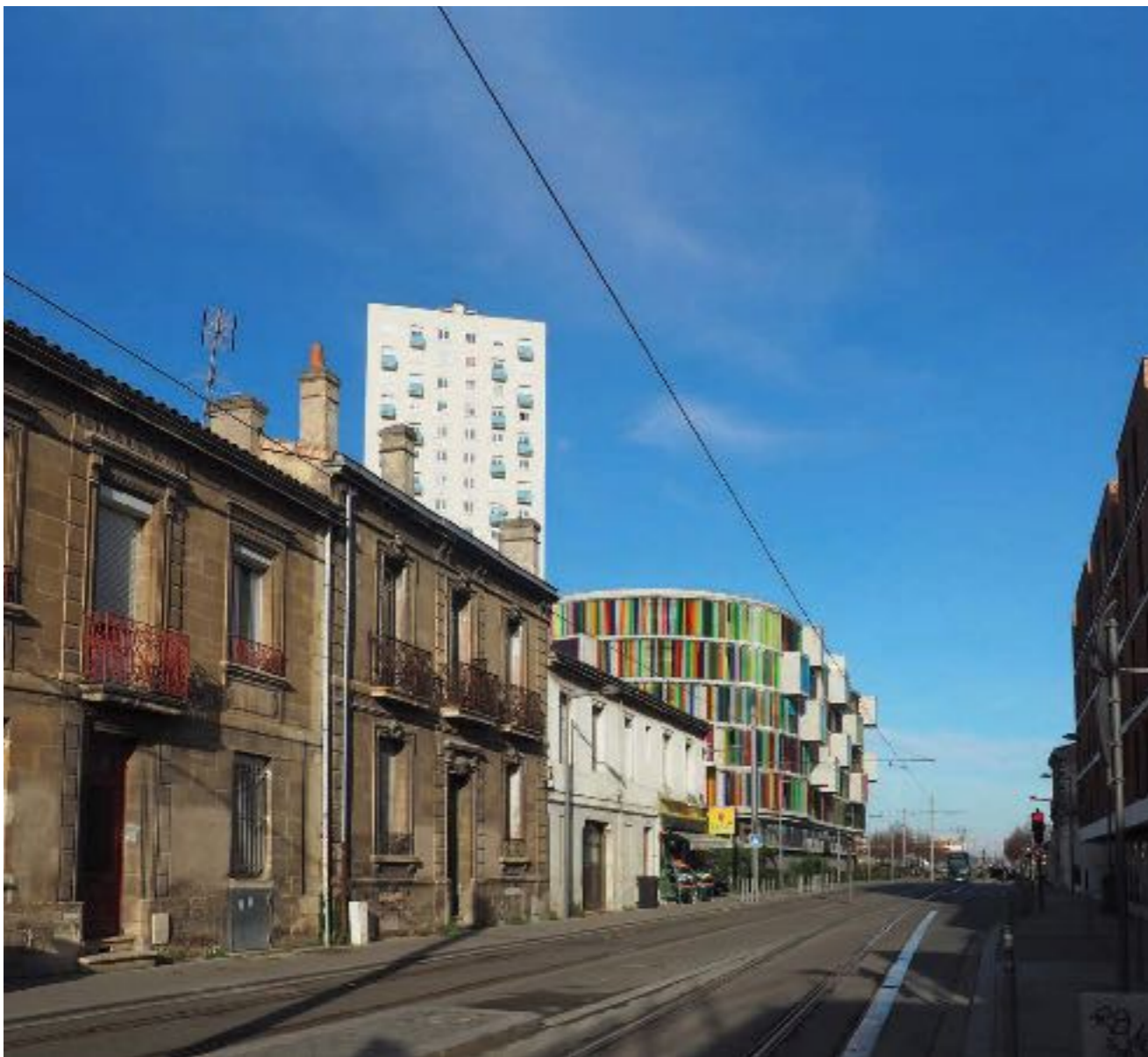
Fig. 4- L'immeuble Arc-en-ciel s'inscrit dans le paysage hétérogène du quartier (© A. Herbert)
