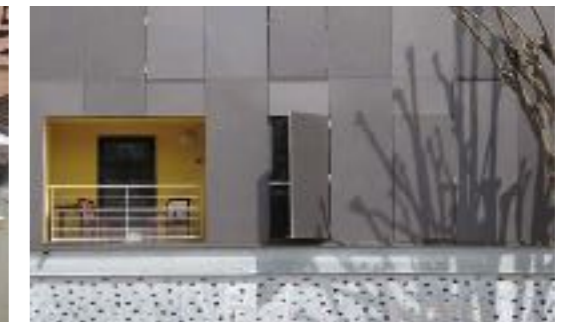
Fig. 8- Les volets mobiles du Stadion par un jeu modulé la façade au cours de la journée (©A. Bousignes)
