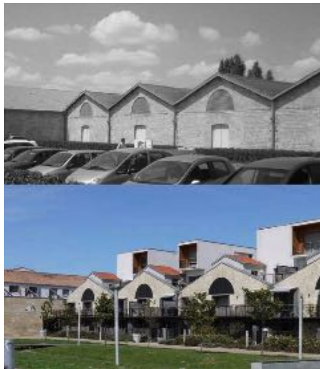
Fig. 5- À Village Bacalan, les anciennes façades sont ajourées et le contemporain émerge entre les pignons pour ponctuer et souligner l'ancien (© Leclercq & Associés / © Ch. Moneix)
