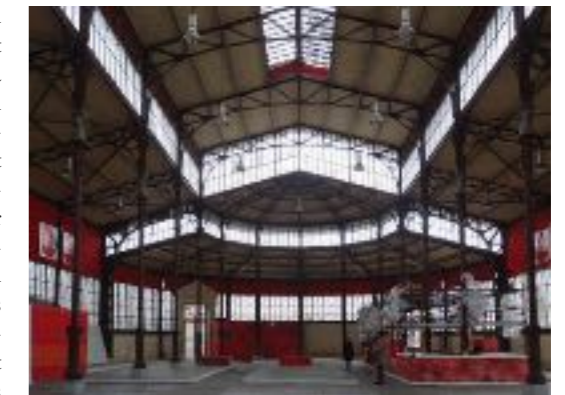
Fig. 5- La halle du marché des Douves avant sa nouvelle fonction (© Ch. Callais)
