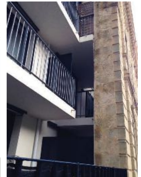
Fig. 6- Espace sombre entre la façade ancienne et l'appartement (© V. Caubet)
