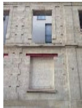
Fig. 8- Les fenêtres murées du rez-de-chaussée dissimulent le parking (© V. Caubet)
