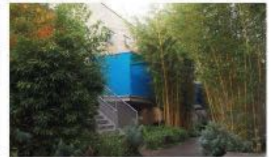
Fig. 11- Depuis la livraison de l'ouvrage, la végétation s'est développée et fait de l'espace central un vrai poumon vert au cœur du projet du cours du Médoc (© Ch. Monney).
