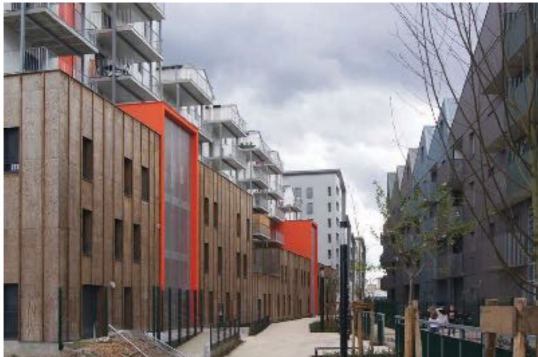
Fig. 13- Sente piétonne aux Bassins à flot : à gauche ADH et à droite ANMA architectes (© Ch. Callais)
