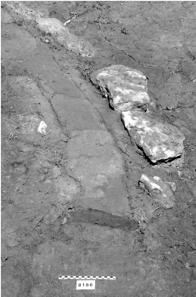
Fig. 10 : Vue de détail du mur en terre massive MR53638 au niveau de l'abside orientale du UNF139. À noter la bande correspondant au sédiment argilo-sableux utilisé pour l'élévation ancrée dans une base argileuse de couleur gris foncé et le renfort de pierres situé à l'extérieur, contre la paroi.
