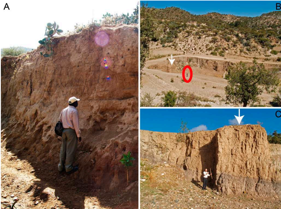
Fig. 7 – Érosion dans des accumulations détritiques en fond de vallons.
