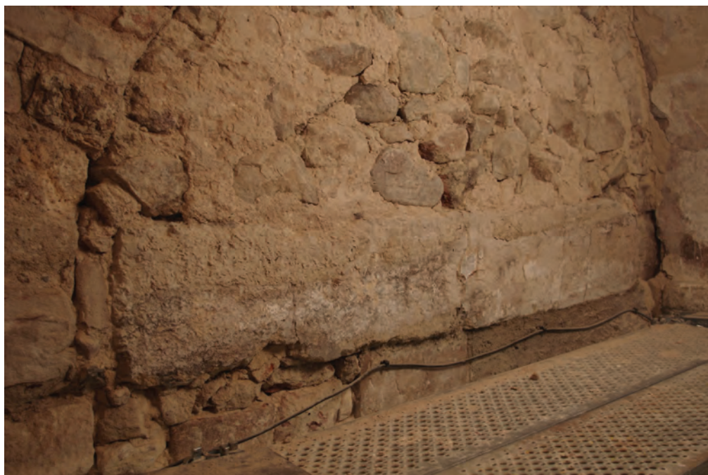
a. Linteau monolithe en calcaire dur.
