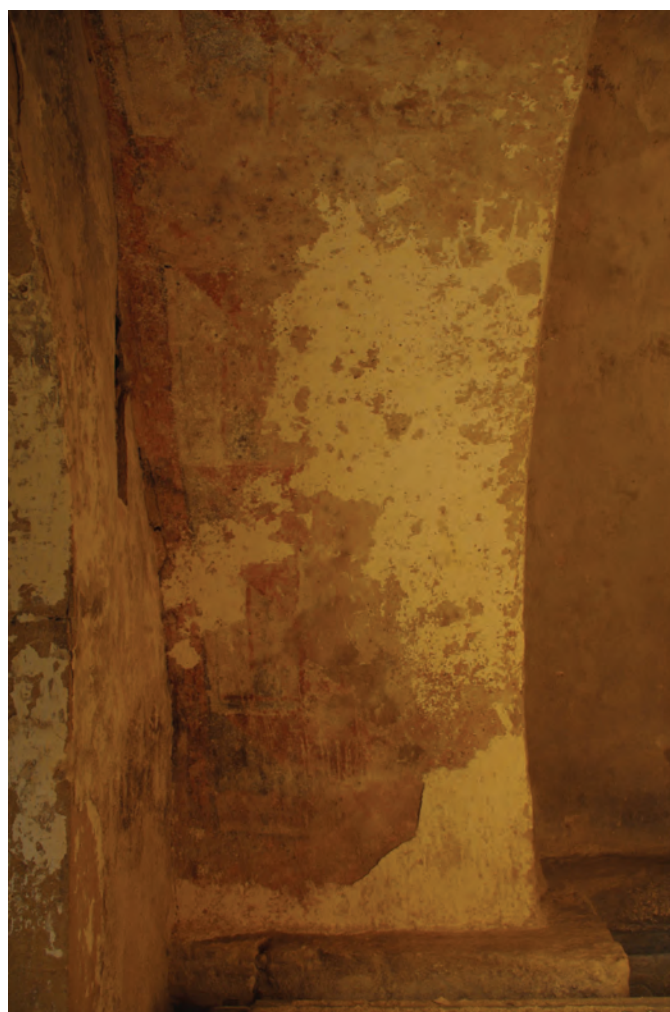
a. Massif d'angle sud-est, retombée méridionale de l'arc après décroûtage partiel.
