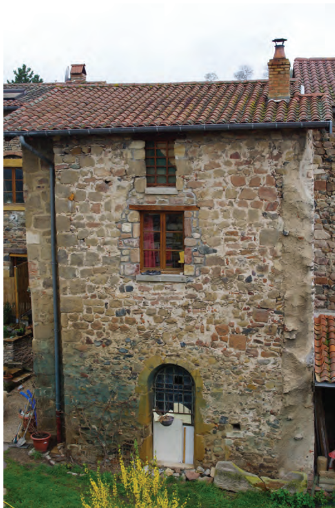
a. Vue d'ensemble. L'arrachement visible à droite correspond au mur mitoyen à la chapelle et à l'église.
