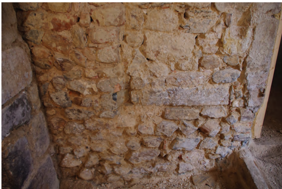
a. Sous le seuil de l'ancienne arcade, structure en saillie qui soutenait sans doute un escalier.
