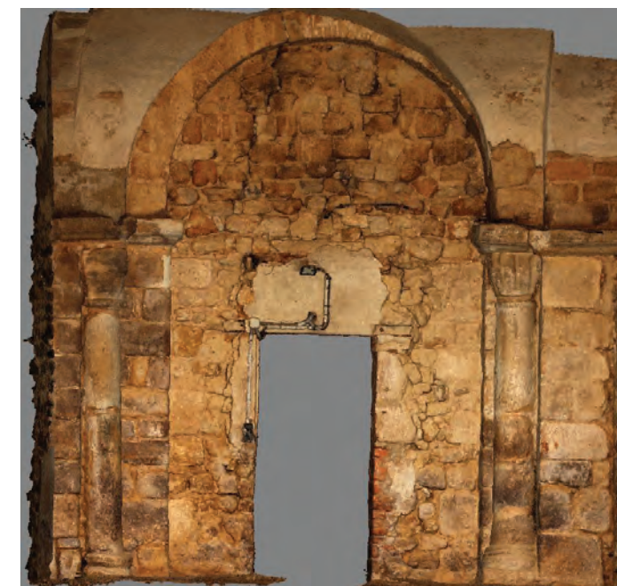
h. Mur ouest.
