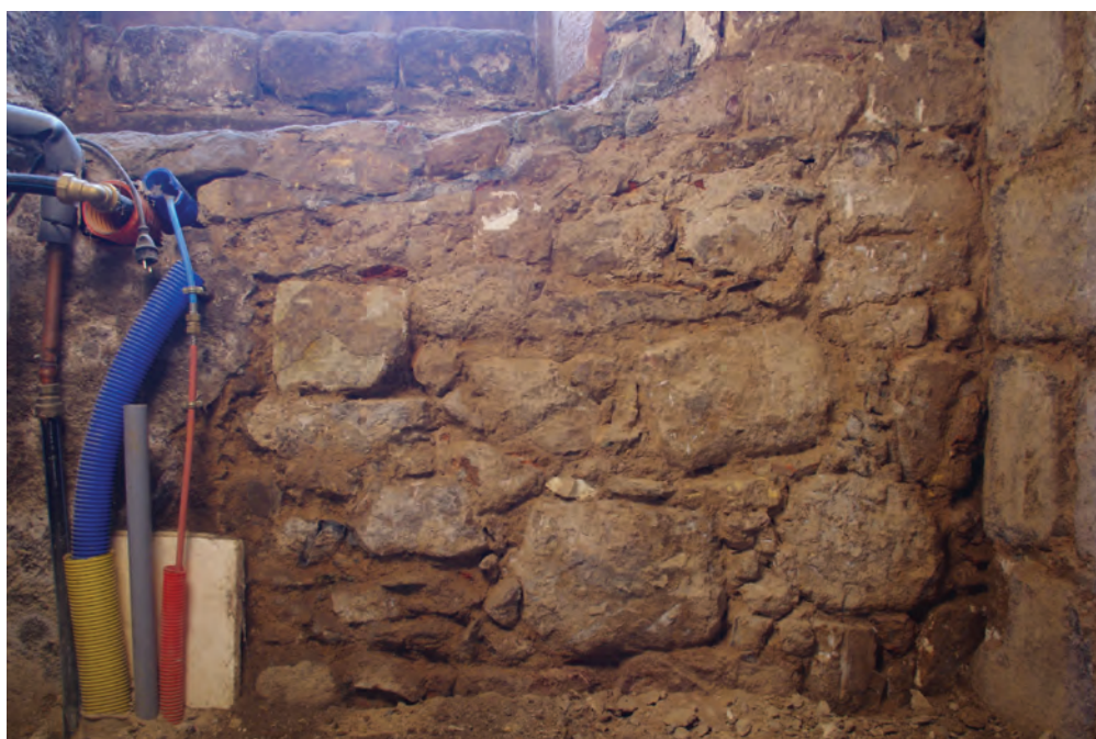
a. Maçonnerie accolée au massif d'angle sud-est.
