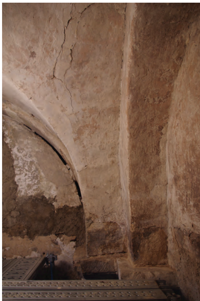
a. Angle du mur et retombées méridionales de la voûte et de l'arc ouest.
