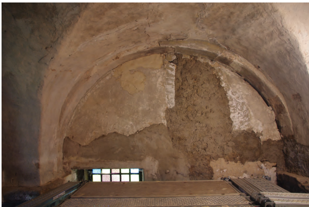
a. Sommet du mur avec les différents revêtements modernes.
