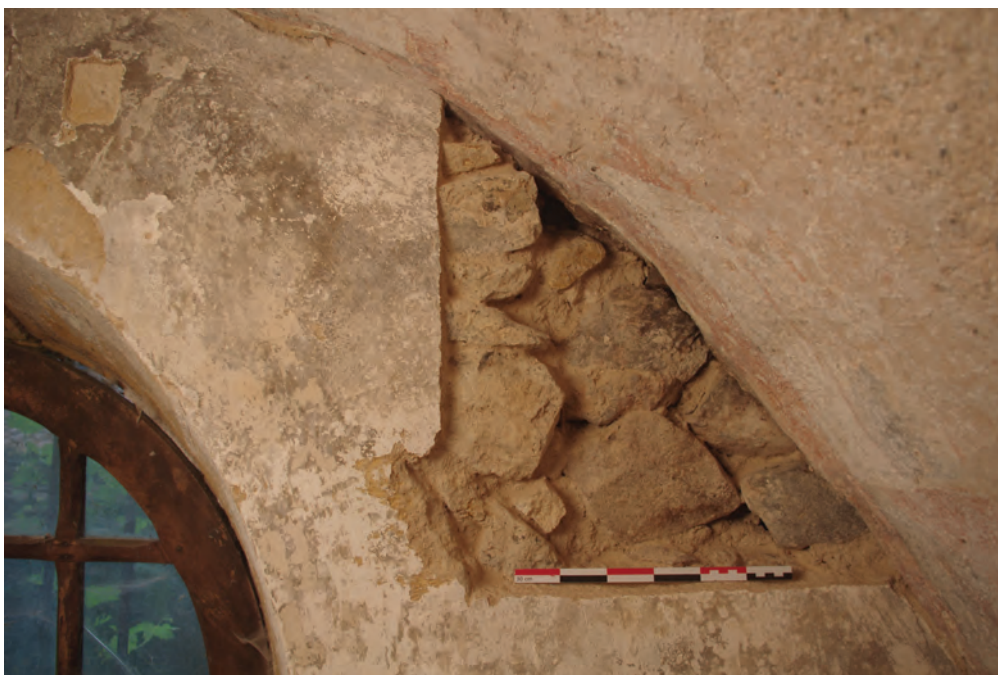
a. Petit sondage montrant la jonction entre le mur et l'arc.
