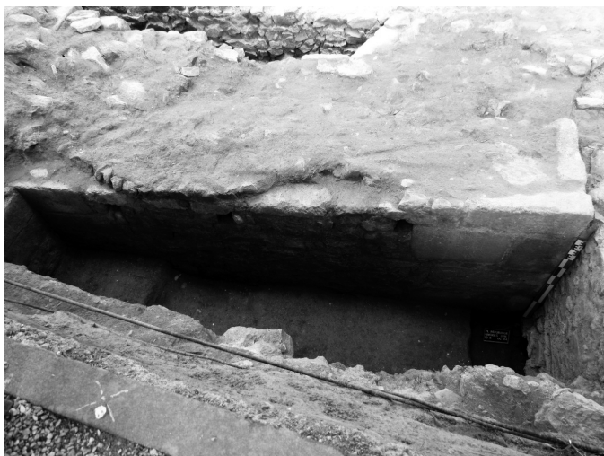
Fig. 5 - Vue du parement interne (UC 414) du mur du déambulatoire présentant trois trous de boulins.
