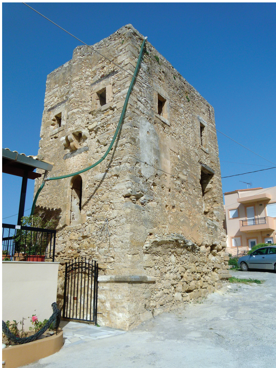
Fig. 2 - Vue générale de la maison-tour depuis le sud-ouest (Cliché V. Rinalducci, CNRS)
