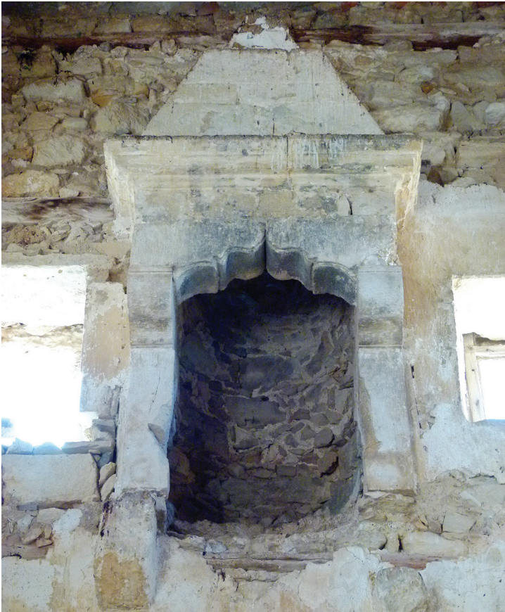
Fig. 10 - Vue de la cheminée du deuxième étage, depuis le nord (Cliché V. Rinalducci, CNRS)
