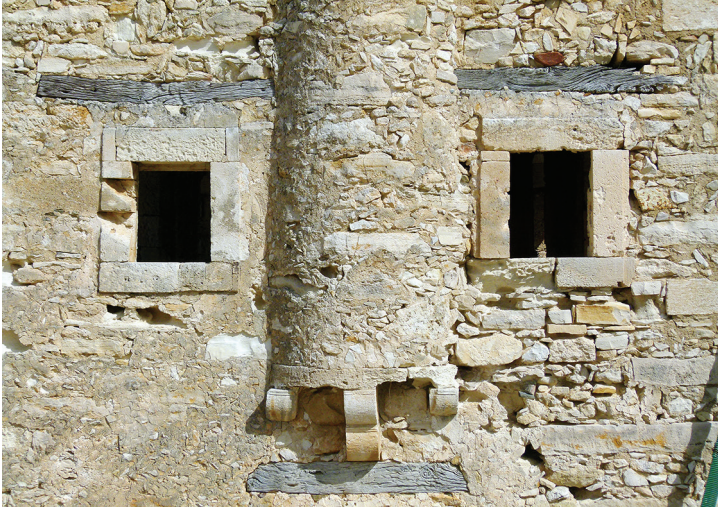
Fig. 9 - Vue du deuxième étage de la façade occidentale de la maison-tour, depuis l'ouest (Cliché V. Rinalducci, CNRS)
