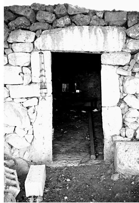
Fig. 8. – Entrée de la bergerie construite près de la chapelle d'Aghios Antonios (cliché H. Wurmser, EFA).
