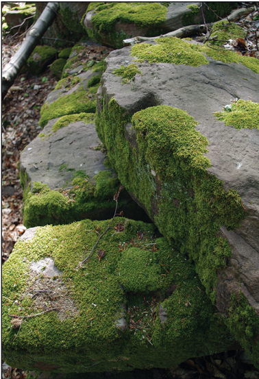
Fig. 21 : Vues du "mur païen"
