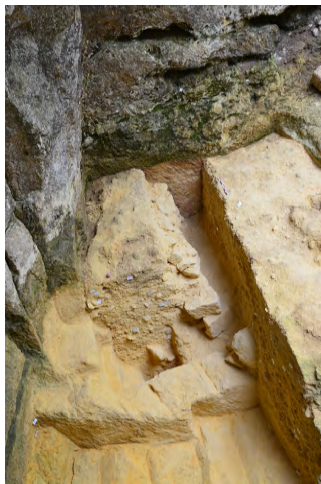
Fig. 38 - Vue générale depuis l'est du mur F.23
