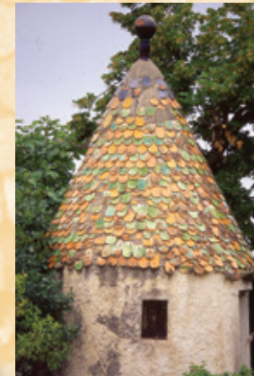
Ollières, toit d'un pigeonnier, cliché : CNRS-LA3M.
