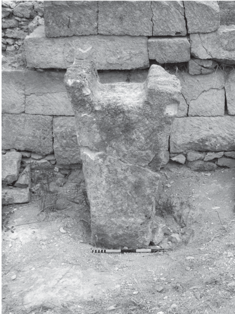
Fig. 10 – L'autel en pierre du bâtiment dit « au trône » (Mission de Ras Shamra, photo K. al-Bahloul).
