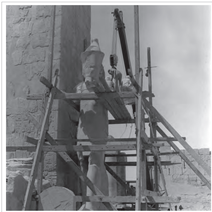
1. Remontage du bras. Cliché d'Alain Bellod (1984).
