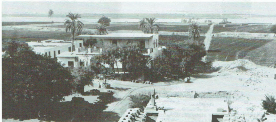
Fig. 12. La maison de Georges Legrain et ses alentours en 1910. Quinze ans après son arrivée, Georges Legrain a fait construire l'essentiel des bâtiments de la Direction des Travaux de Karnak qui constituent encore aujourd'hui les locaux du CFEETK, cliché 4-1/46 (© G. Legrain, CFEETK 16868).
