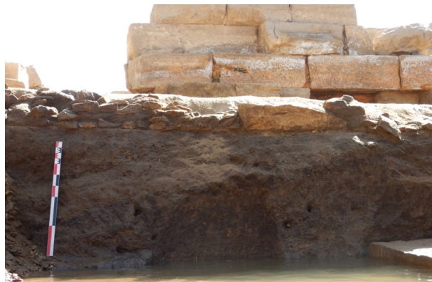
Fig. 6. Au premier plan, muret (SB076) en bordure de la fosse de fondation (FOS075) du mur arrière (1 re assise à droite) ; au second plan, le mur nord du déambulatoire et le sable de fondation (US062). © CNRS/C. Thiers (17149_2019_NDMPF_007).
