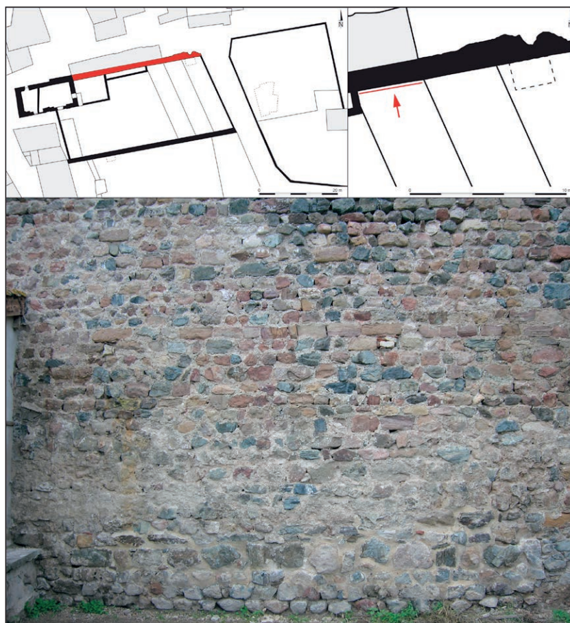
Fig. 22 Emprise de la nef, étude du bâti sur le parement interne du mur gouttereau nord : détail de la maçonnerie M 3, appuyée sur la harpe d'attente de la maçonnerie antérieure (cl. Olivia Puel, 2009).
