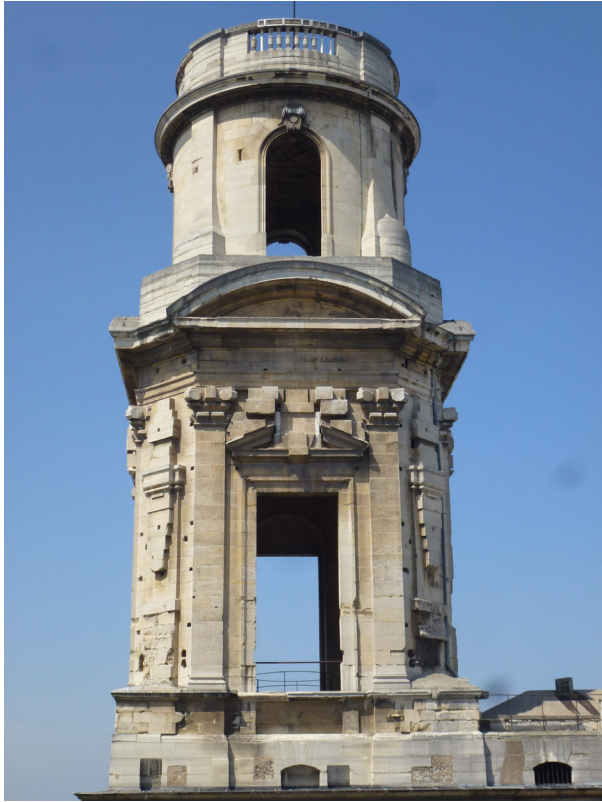
Fig. 4 : Vue de la tour sud sur son flanc oriental. Etat actuel. Cliché Léonore Losserand, juillet 2016.
