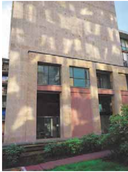
Articulations entre les éléments hauts et les éléments bas : retrait, traitement de façade, percements
