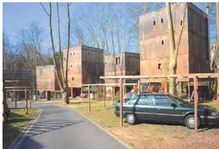
Le hameau de Platoun, comprend 39 maisons à ossature bois en accession à la propriété. Cette opération prévue dans le cadre de l'opération ANRU est réalisée sur les terrains initialement prévus pour la deuxième tranche. Sa démolition est actuellement envisagée en raison de vices de construction.
