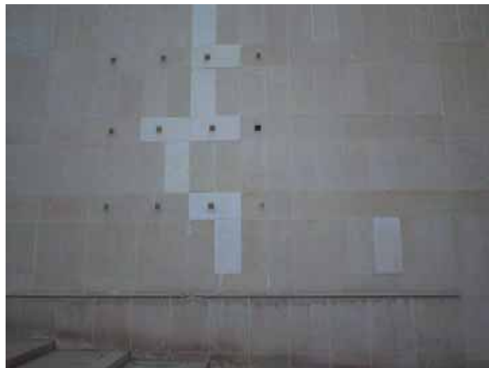
Remplacement de quelques parties en pierre des pignons
