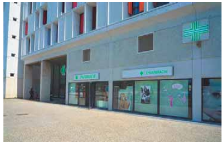
Les commerces côté parking: ici le pôle santé.
