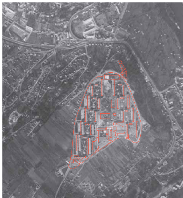
Vue aérienne 1961, pendant le chantier, Source ING
