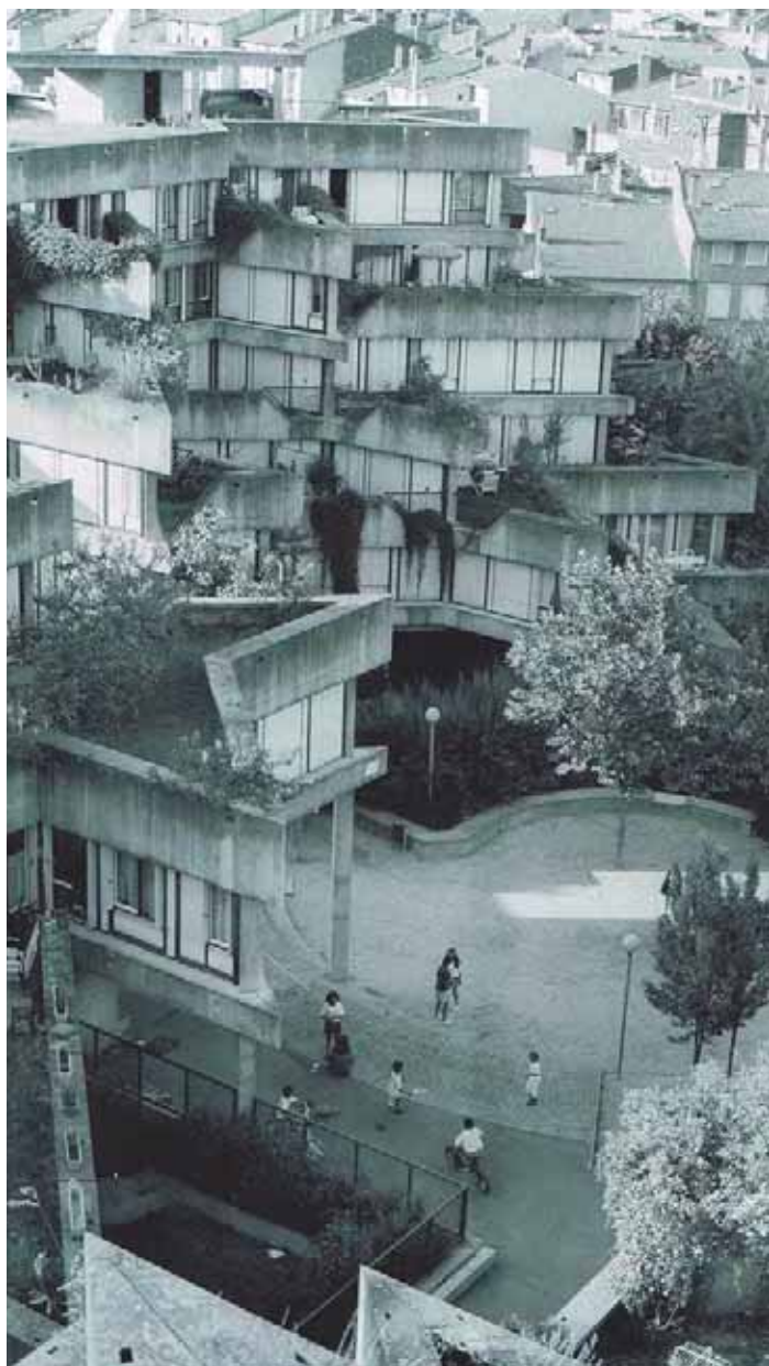
Placette arrondie et théâtre de plein air, place du Côteau, photo d'époque
