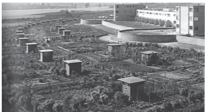
Le front bâti sur la vallée de la Nida et les jardins ouvriers dans ca Siedlung Römerstadt à Francfort
