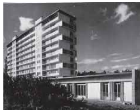
Photographie bâtiment H
