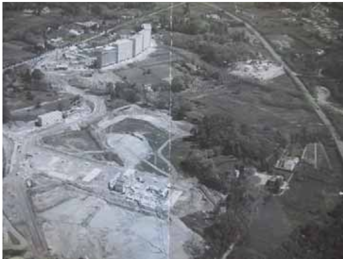
Le chantier durant le premier triennal. Photo archives départementales Bayonne
