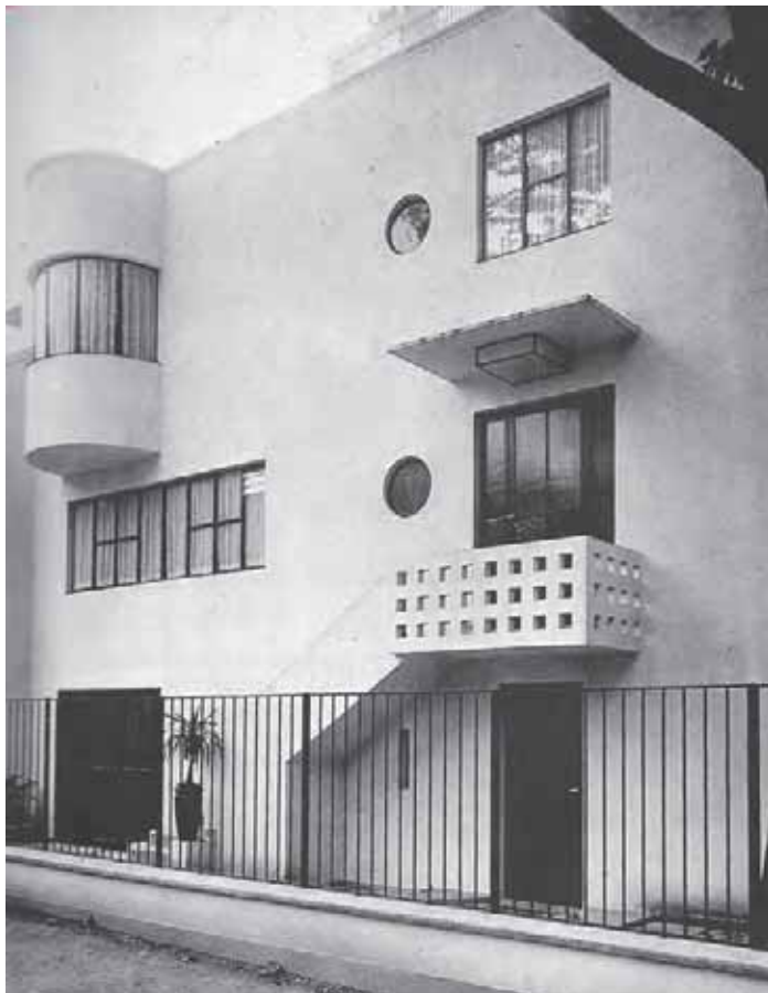
Le thème récurrent du volume hémicylindrique tient une place importante dans l'expression plastique dans l'architecture de Lurçat.: haut maison Bomsel, bas cité du Werkbund autrichien, à droite immeubles ISAI à Maubeuge
