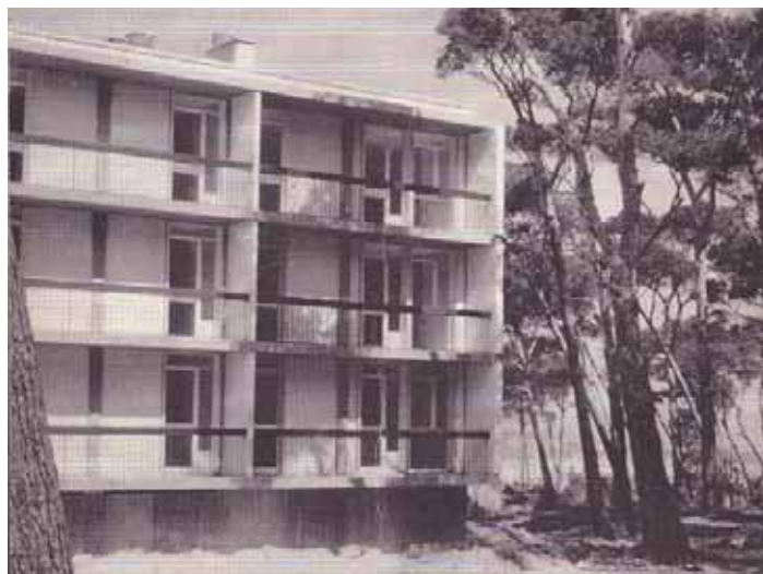
Photographie d'un immeuble de la 2e tranche, 1964, www.titidegun.fr
