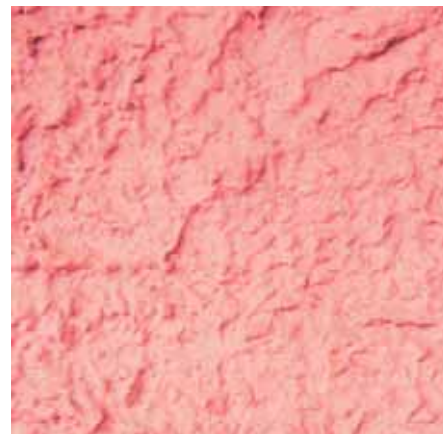
Enduit, couleur lie de vin (en RDC)
