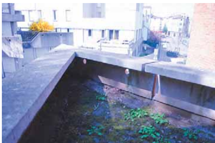
Les parapets assemblés avec des angles en biseau
