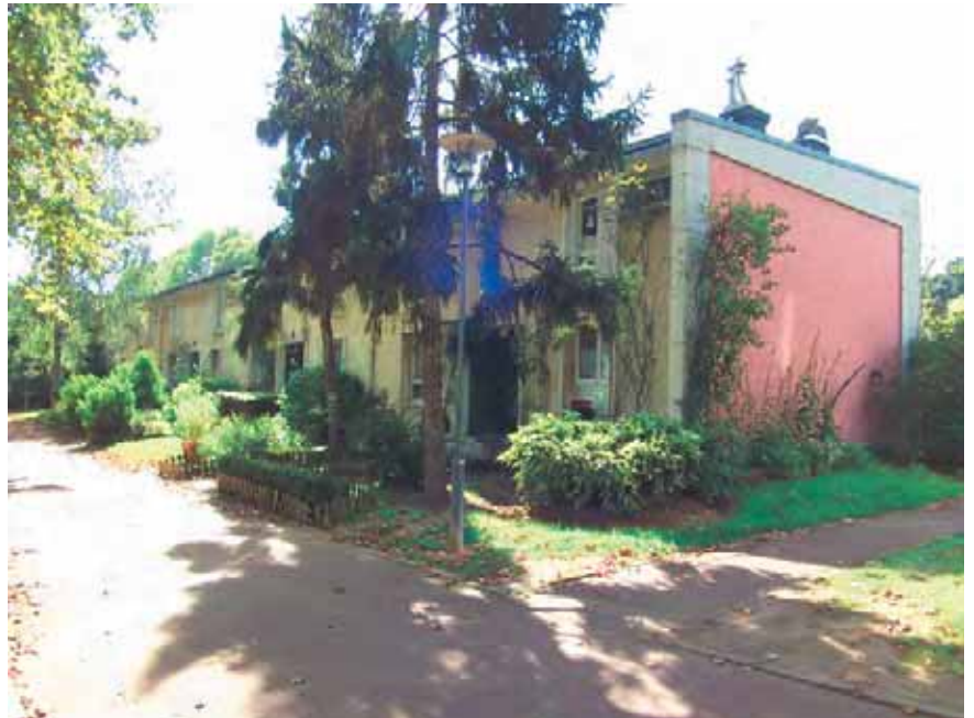
Installation de jardins privés, rue Jacques Rivière, Photographie J. BISSERIER, Septembre 2011
