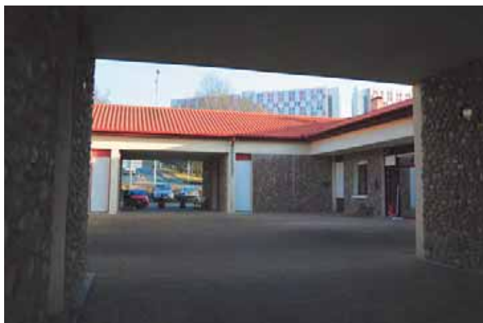
La partie haute du centre commercial
