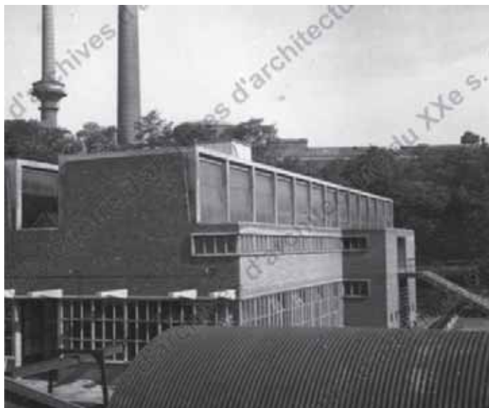
1949-. Bâtiment des ateliers-vestiaires de l'usine de préparation mécanique, pour les Houillères du bassin de Lorraine, Merlebach (Freyding-Merlebach, Moselle) : vue ext., n.d. (cliché anonyme). (Objet AILEM-B-49-1. Dossier 078 Ifa 2004/3. Doc. AR-19-11-10-16).
