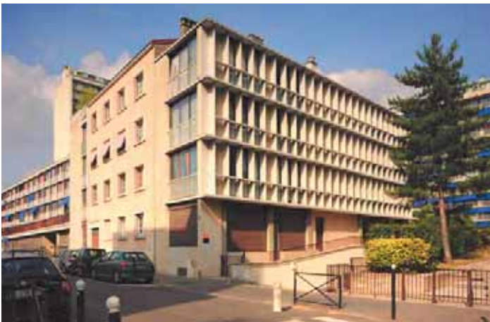
Insertion d'un immeuble existant dans l'opération
