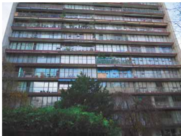
Changement partiel des baies vitrées
