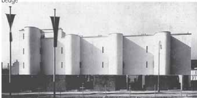
Le volume hémicylindrique des escaliers détaché du plan de la façade par les étroites fenêtres verticales des immeubles nord - (Dossier 200 Ifa 788)
