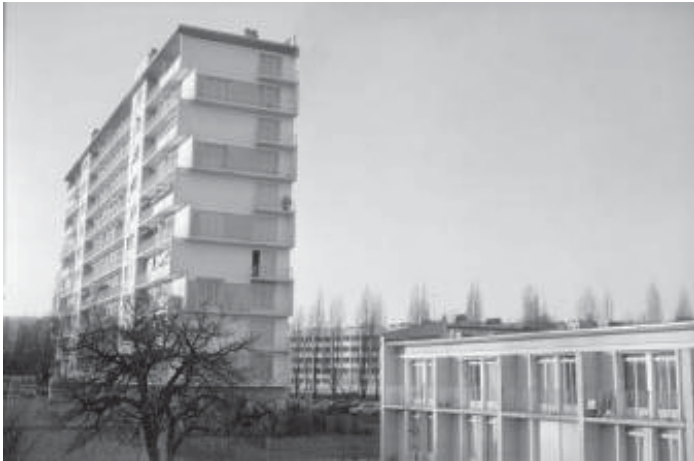
Vue sur les bâtiments L et H, 1960
