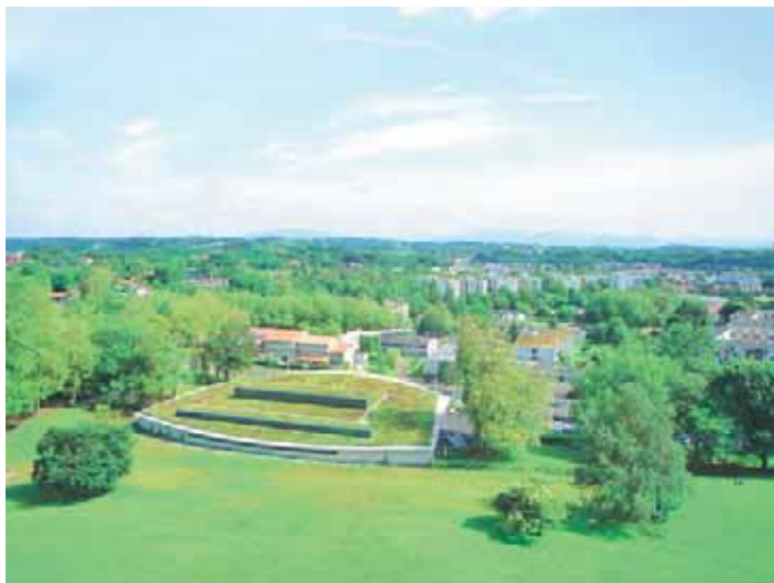
La toiture végétalisée du centre nautique.
