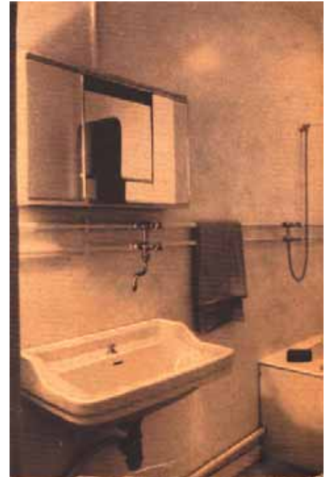
La salle de bain avec les robinetteries prises directement sur les alimentations circulant sur le mur
