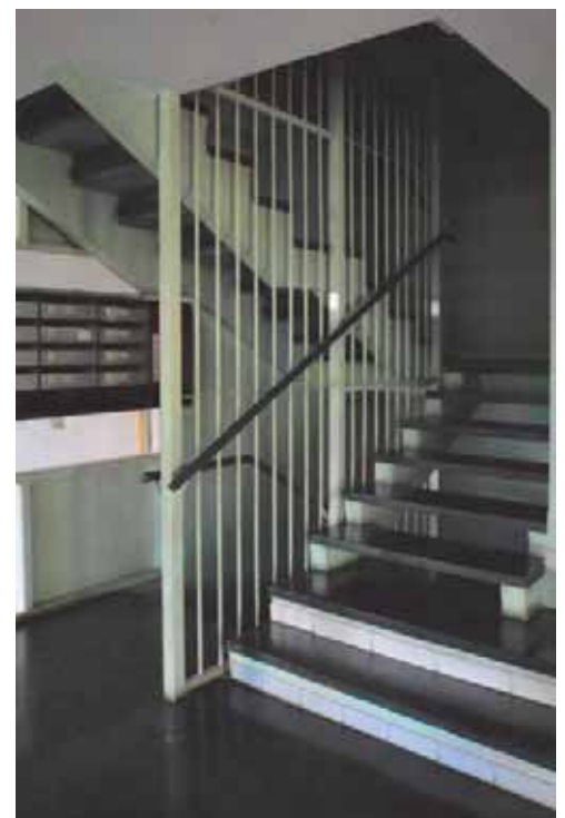
L'escalier ouvert est éclairé naturellement depuis le hall et depuis la couverture grâce à au jour des contre marches
