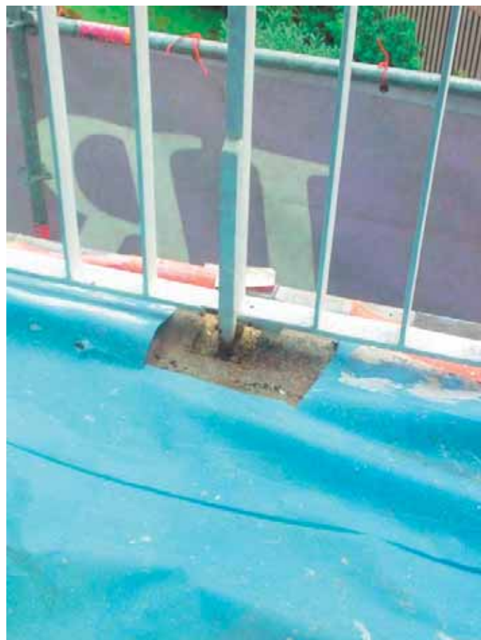
Travaux de ravalement des balcons
