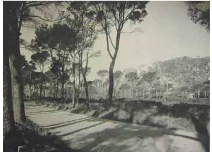
Photographie du terrain avant la construction, IFA, Fonds Gillet, 152 lfa 8/4
