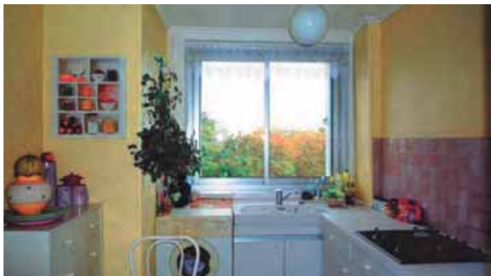
Ci-dessus: cuisine état actuel. Diminution du clair de vitrage en raison de l'épaisseur des montants et de l'empiétement des jalousies PVC Ci-contre: Cuisine état original. L'agencement fixe sans doute conçu par Gascoïn
