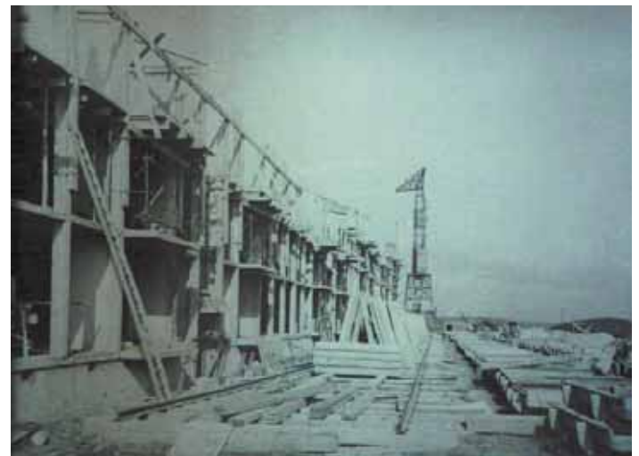
Les pièces préfabriquées stockées devant le bâtiment en construction et le chemin de grue
