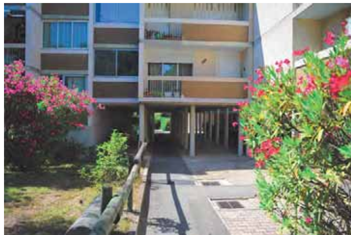
L'accès aux halls de la tranche 1 au travers des jardins et des portiques
