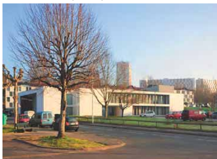
La Maison de Solidarité Départementale à l'ouest de la place des Gascons
