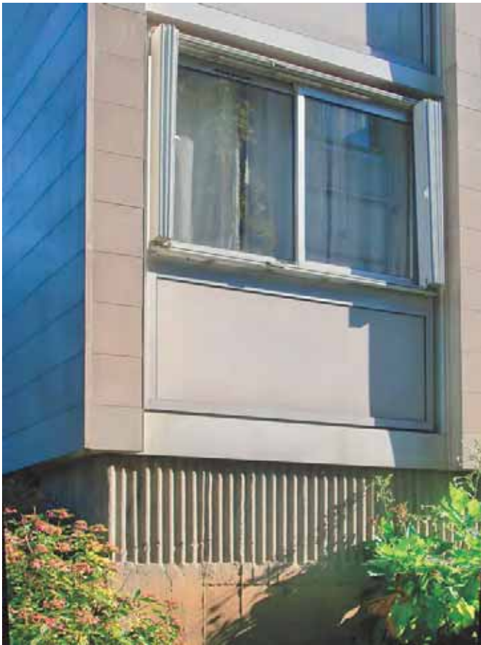
Ci-dessus: Socle, poteau d'angle, pignon - État d'origine Bibliothèque Kandinsky Fonds Cardot Joly Ci-contre: Le poteau d'angle englobé dans le doublage.
