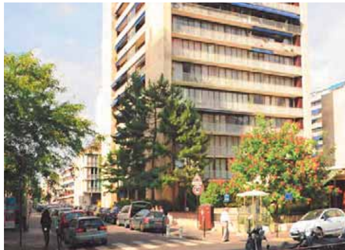
L'élargissement de la voirie au croisement de la rue du Point-du-Jour et de la rue des Longs-Prés a été clos.
