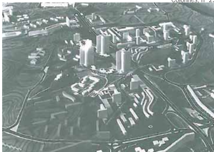
Maquette de la ZUP n°1 de Marseille, 1960-1966, G. Gillet, archi. Colennes, n° 25
