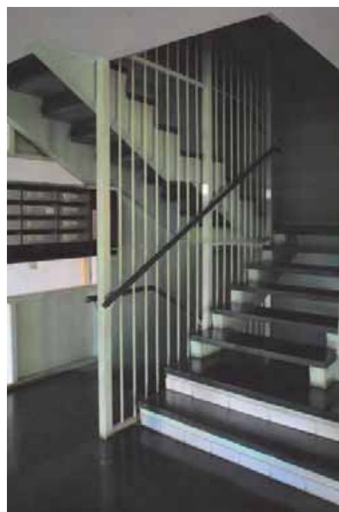
L'escalier ouvert est éclairé naturellement depuis le hall et depuis la couverture grâce à au jour des contre marches
