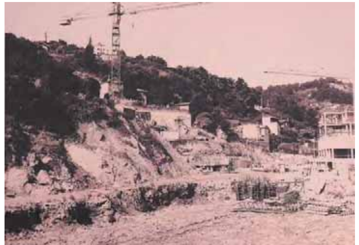
Les premiers travaux de terrassement et de confortement Photos Archives Municipales de Givors
