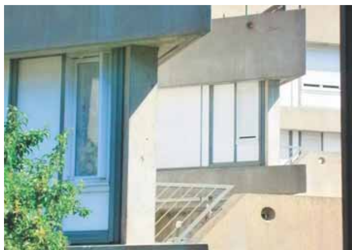
Typologies de volets en place: en haut, volets roulant pvc ci-dessus volets accordéon pvc ci-dessous volets accordéon en métal Photos © Benoît Carrié , 02/04/2012
