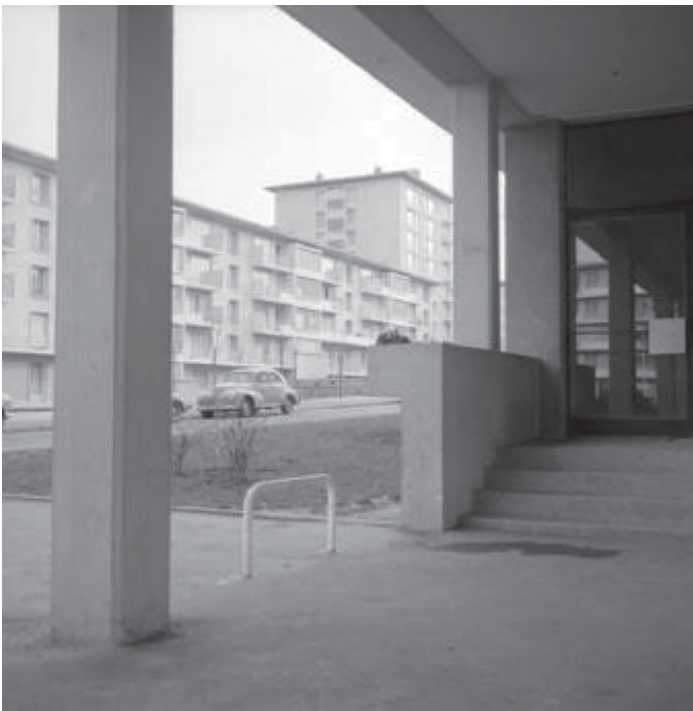
Porche du bâtiment C, 1960 Bibliothèque Kandinsky, centre Pompidou, Fonds Cardot –Joly, 3505 BEAUD b
