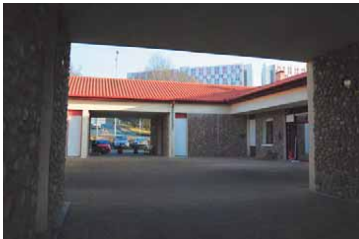
La partie haute du centre commercial
