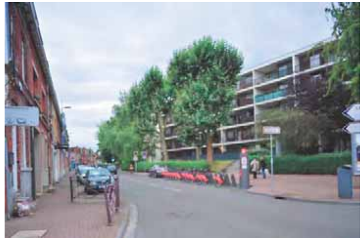
Photographie actuelle de l'immeuble Breteuil depuis la Carrière de la Funquée, ph. B. Carrié
