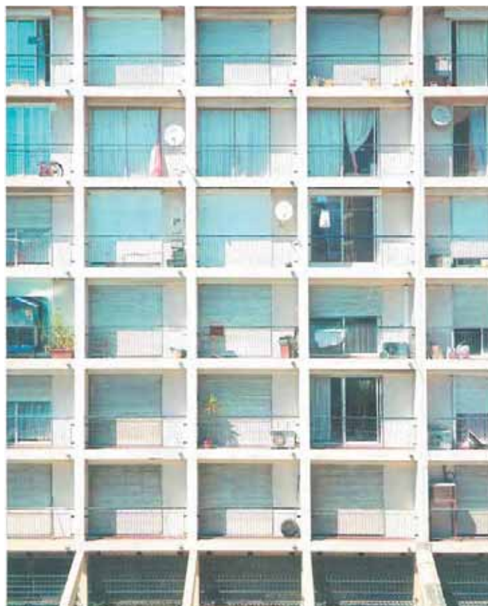
Expression de la grille constructive en façade, caractéristique des ensembles ; La Bourse, Marseille, 1962, Boileau & Henri-Labourdette, archi. Durousseau 2009.
