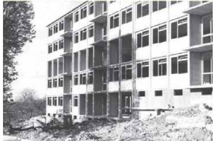
Le chantier avec les façades partiellement montées
