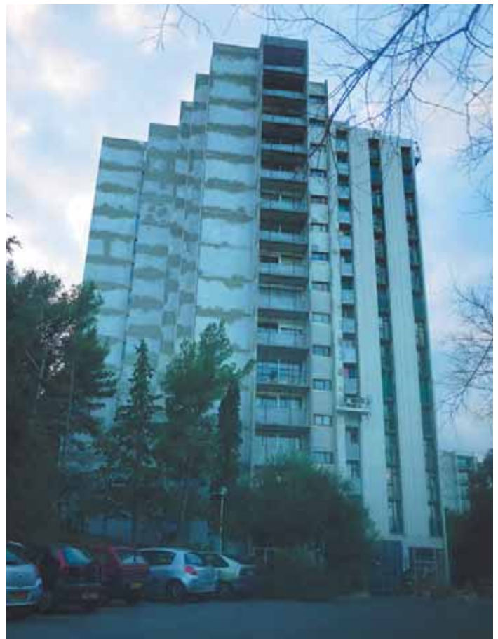
Ravalement de façade en cour
