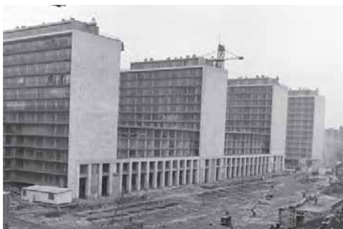
Photographie de chantier, LUCAN, 2003 p.106-109
