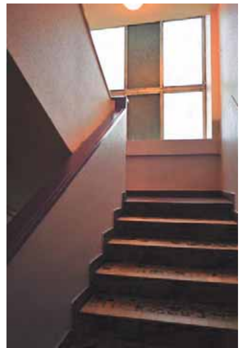
Dispositif d'entrée actuel et escaliers bâtiment B Photos bc-a
