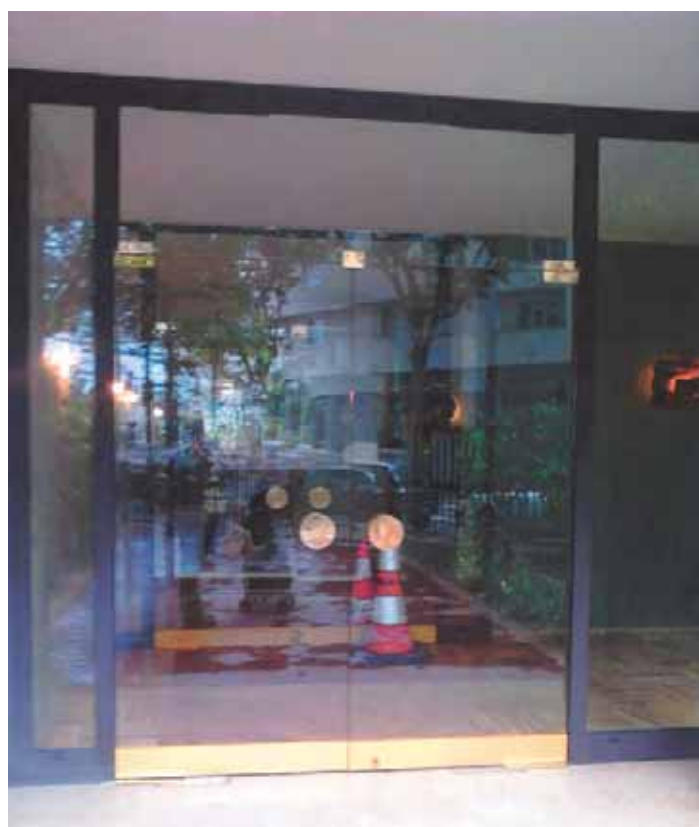
Porte récemment modifiée dans l'esprit originel mais avec élargissement des ouvrants
