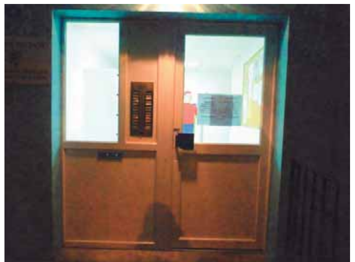
Ci-dessus photo Lucile Pierron BC-A L'absence d'espace intermédiaire entre l'entrée du logement et l'escalier constitue une source d'inconfort acoustique majeure.
