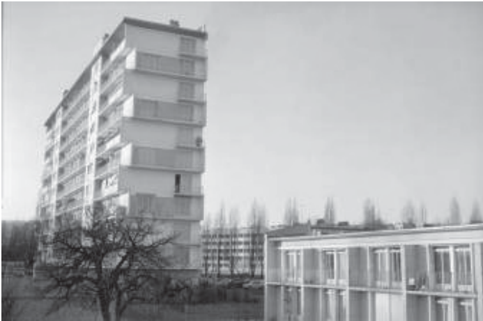
Vue sur les bâtiments L et H, 1960
