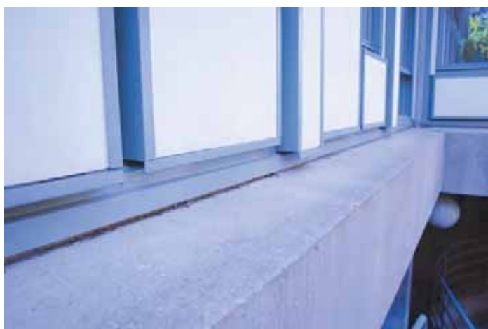
En haut les lisses basses des panneaux de façade endommagées En bas les couvre-joint et lisses basses changées sur les copropriétés Photos © Benoît Carrié , 02/04/2012
