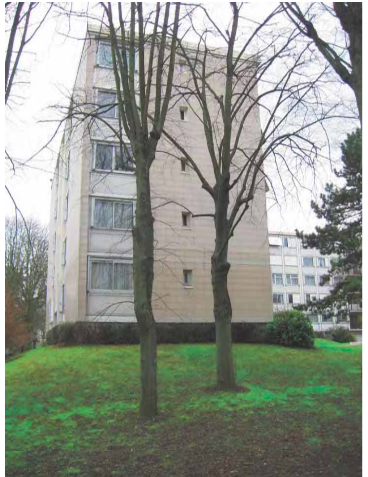
Les pignons et les parties de façade aveugles des bâtiments est/ouest doublés en bardeaux de fibre-ciment.
