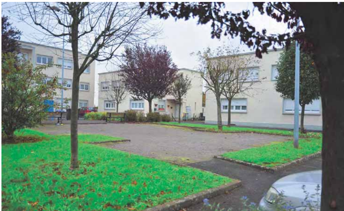
Les cours sur rue état actuel - Photo BC-A
