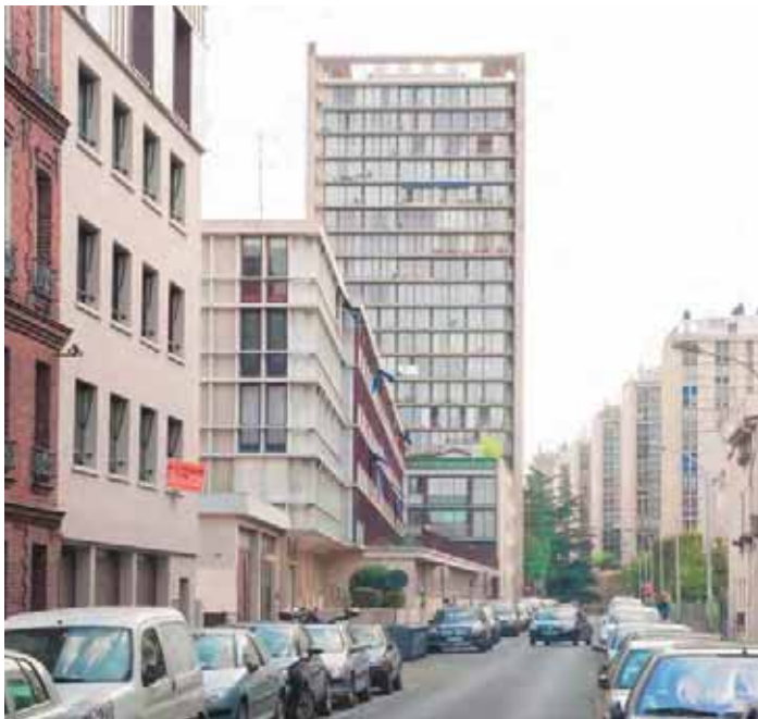
Rattrapage d'alignement et de hauteur rue des Longs-Prés
