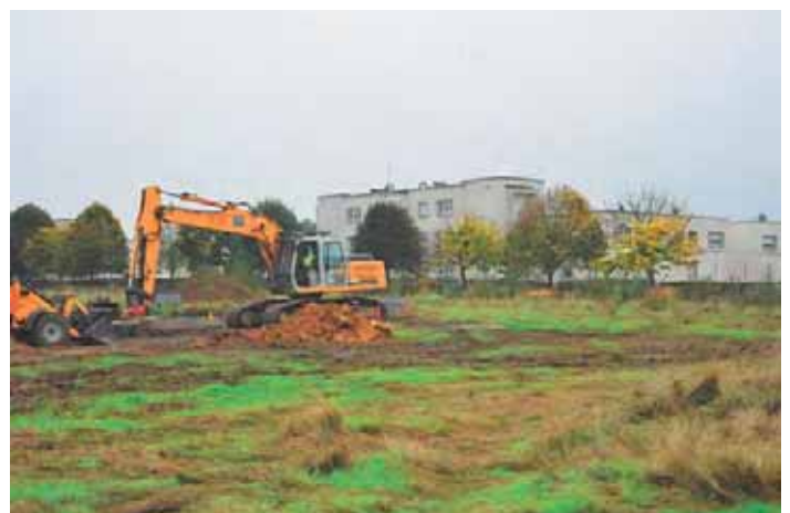
Les travaux de viabilisation du lotissement à l'arrière de l'opération - photo bc-a
