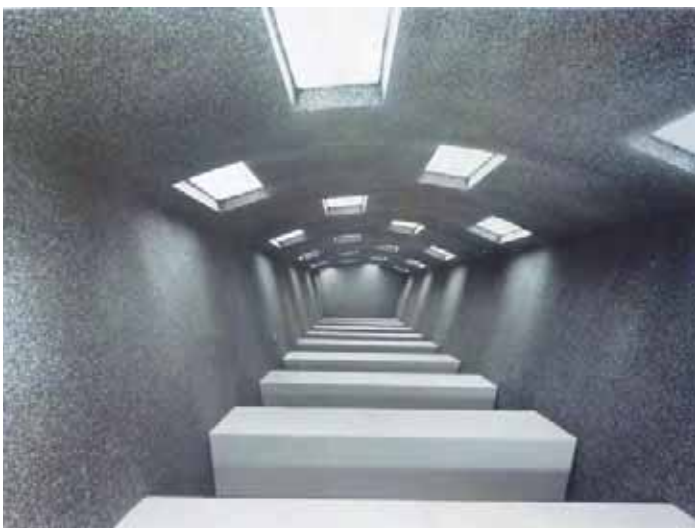
Ci-dessous: Photo Archive IFA 078.ifa 2007 4 Dans le cas des tours paraboliques, le jour entre le palier intermédiaire et la façade, qui propage le son sur toute la hauteur de l'immeuble est particulièrement mal perçu des habitants. Intervention complexe et onéreuse, l'encloisonnement de l'escalier qui résoudrait les problèmes de sécurité et les problèmes d'acoustique est ici réalisable sans intervention sur l'extérieur.
