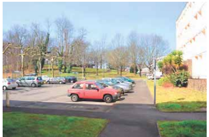
Dans les cours de la partie basse, un alignement de platanes occupe le centre du parking et des bordures parfois très bien plantées forment un avant plan végétal très agréable pour les façades
