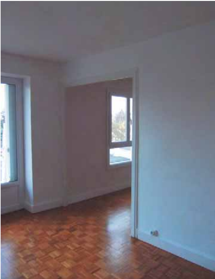
Installation d'huissierie entre le séjour et la chambre
