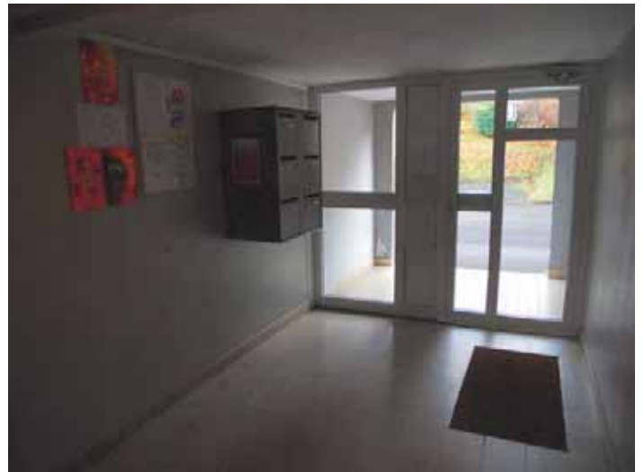
Photos Lucile Pierron BC-A Les diverses solutions retenues pour le changement des portes d'accès des bâtiments bas.
