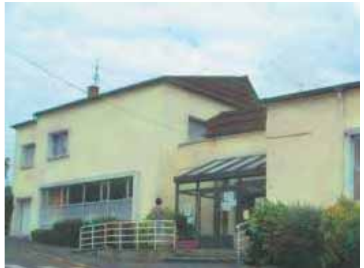
L'école maternelle défigurée par de multiples interventions a perdu toute qualité architecturale - Photo site internet mairie de Boussois
