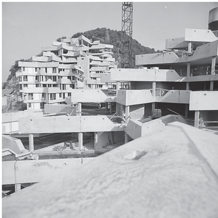
Les Etoiles en construction, Bibliothèque Kandinsky Fond Cardot Joly
