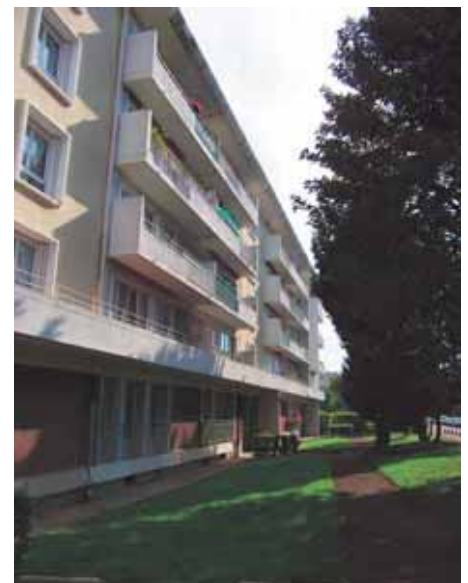
Bâtiment F, balcons en saillie et alternance entre garde corps pleins et garde corps léger
