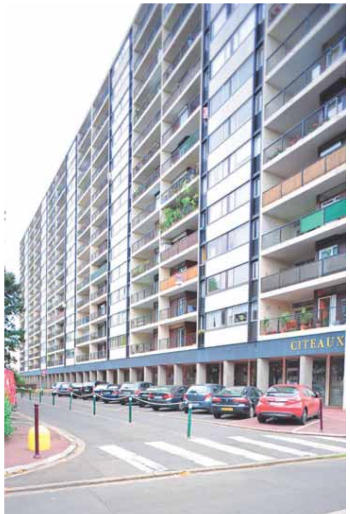
Modifications apportées par les habitants aux garde-corps de l'immeuble « Citeaux » ph. B. Carrié
