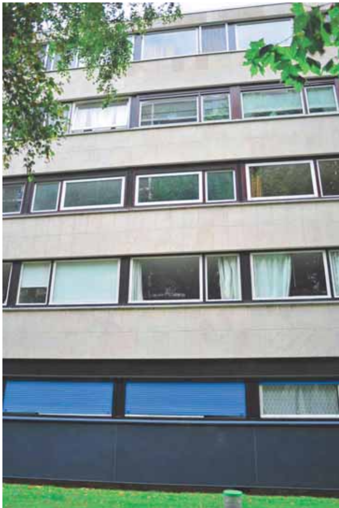
Changements de plusieurs menuiseries de l'immeuble « Breteuil », ph. B. Carrié
