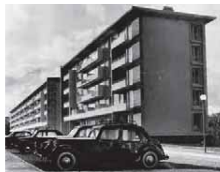
Photographie bâtiment B
