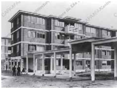
Cité du Champ-des-Oiseaux, Bagneux : vue extérieure d'un bâtiment en fin de chantier
