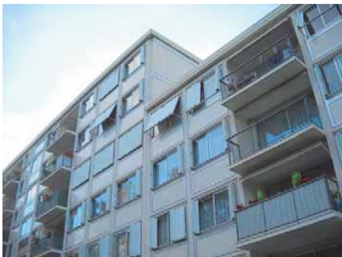
Photographie détail toiture, Lora Dimitrova, 12 février 2012
