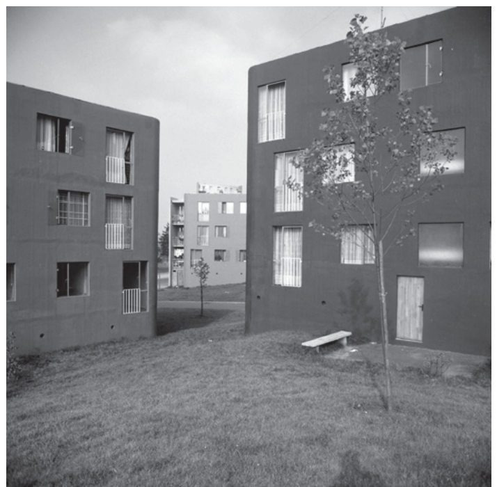
Ci-dessous et ci-contre: Photographies anciennes de façades de tours de logements (Objet AILEM-B-59-2. Dossier 078 Ifa 3003/3)
