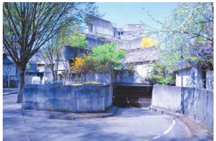
Accès aux parking souterrains Photos © Benoît Carrié , 02/04/2012
