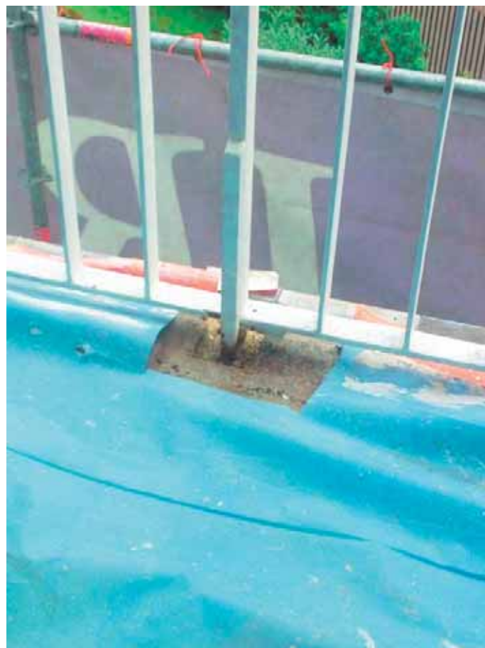
Travaux de ravalement des balcons
