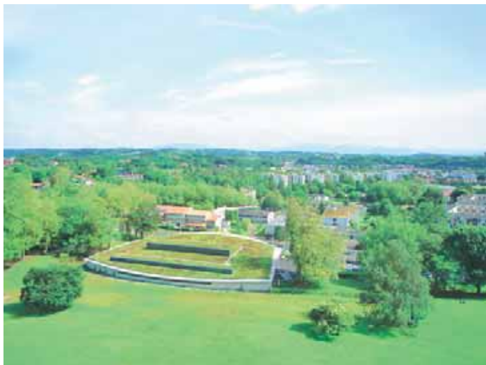
La toiture végétalisée du centre nautique.
