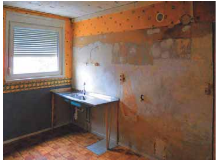
Appartement en travaux - Photo Lucile Pierron BC-A Ci-dessus: Le changement des fenêtres et la pose de volets roulants réduisent de manière importante le clair de vitrage. Ci-dessous: Le cadre dormant incorporé dans le coffrage glissant. On peut voir l'insuffisance de l'isolation thermique.
