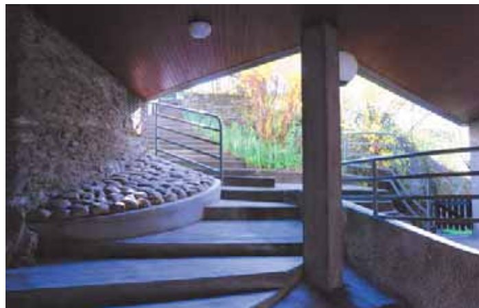
L'escalier à travers les terrasses et passages, état actuel photo © Benôt Carrié, 02/04/2012
