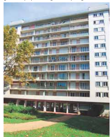
Bâtiment H, balcons courant sur la totalité de la façade
