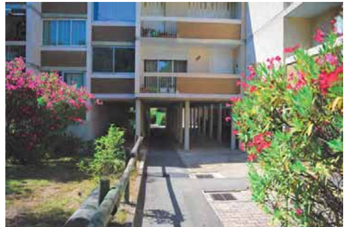
L'accès aux halls de la tranche 1 au travers des jardins et des portiques
