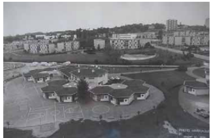
Le groupe scolaire JP Branat rompt avec la conception du plan d'ensemble en adoptant les formes proliférantes et la géométrie hexagonales qui deviennent la norme. A l'arrière, la persistance du tracé de la N117.
