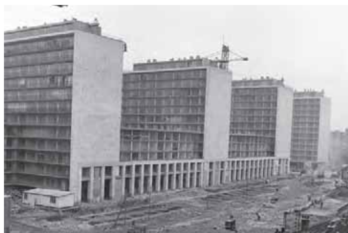
Photographie de chantier, LUCAN, 2003 p.106-109
