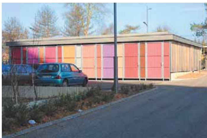
Des bâtiments bas répartis sur le parking offrent des abris sécurisés pour les véhicules à deux roues.
