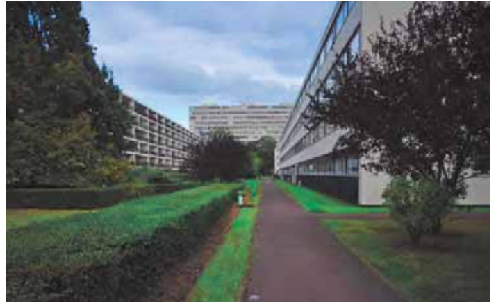
Photographie vers l'immeuble Citeaux, entre Dampierre et Andelys, ph. BCA
