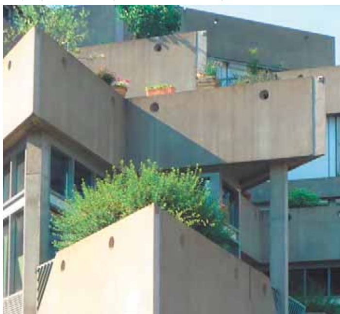
Les parapets assemblés par recouvrement d'une pièce sur l'autre
