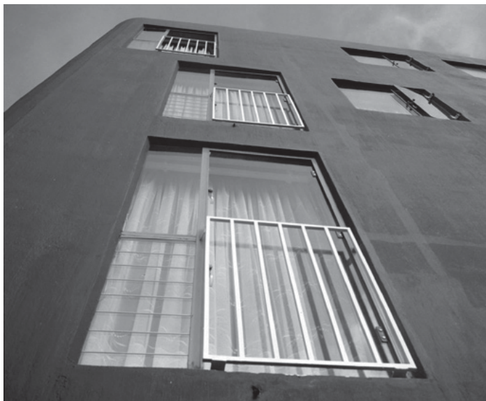
Photographie ancienne d'une baie d'un immeuble bas, fonds Cardo-Joly, bibliothèque Kandinsky
