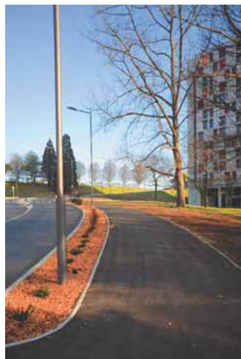
Avenue de la Mounède la piste cyclable forme une contre allée partagée avec les piétons.
