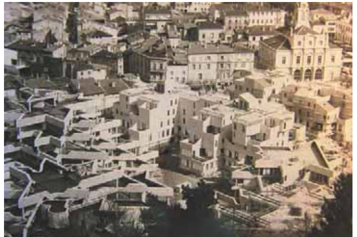
Les Etoiles de Renaudie et les immeubles conçus par le cabinet ETRA, Photo Archives Municipales
