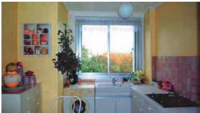
Ci-dessus: cuisine état actuel. Diminution du clair de vitrage en raison de l'épaisseur des montants et de l'empiètement des jalousies PVC Ci-contre: Cuisine état original. L'agencement fixe sans doute conçu par Gascoïn
