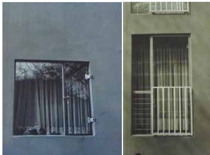
Photographies d'époque d'une fenêtre d'un immeuble bas (Objet AILEM-B-59-2. Dossier 078 lfa 2007/4)
