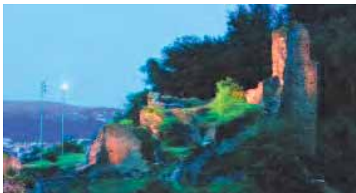
La mise en lumière du château
