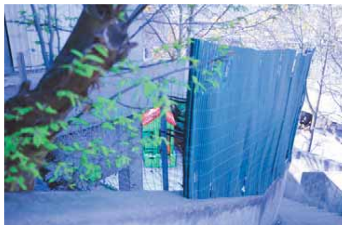
Les clôtures en matériaux bon marché tendent à remplacer les écrans végétaux qui assuraient plus subtilement l'intimité des jardins et terrasses Photos © Benoît Carrié , 02/04/2012
