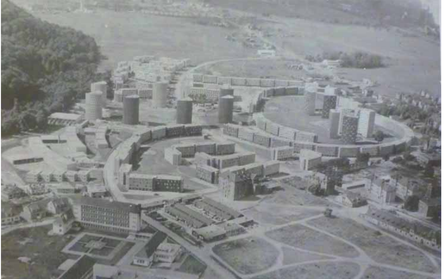
Ci-dessus : photographies de chantier (Objet AILEM-B-59-2. Dossier 078 Ifa 2007/4)
