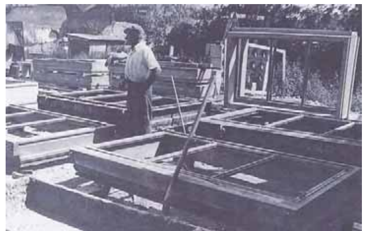
Les cadres préfabriqués avec menuiseries incorporées à Maubeuge
