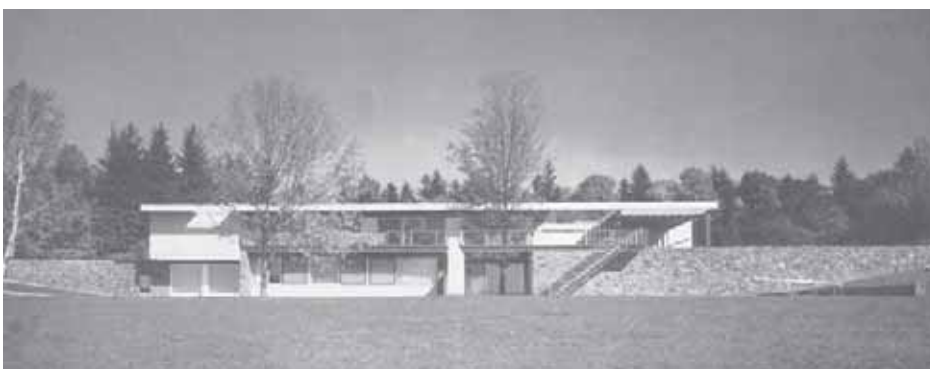
Maison Gagarin, Lichtfeld, Connecticut 1954/55
