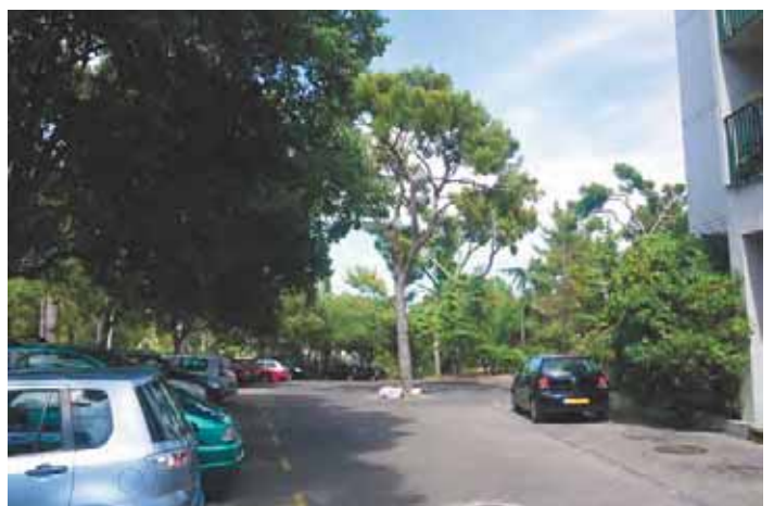
Stationnement des voitures en désordre, surtout au pied des tours, faute de parking, photographie prise en 2012.
