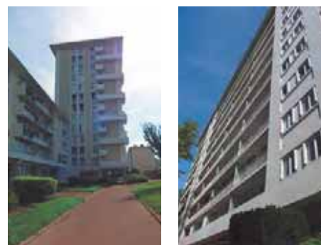
Vue sur la tour U (gauche) et façade bâtiment H (droite), sept. 2011
