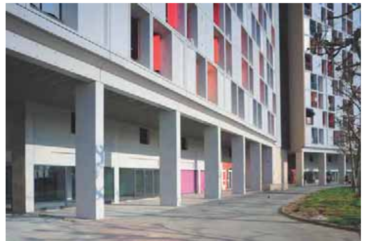
L'ouverture des rez-de-chaussée et la peinture des panneaux de galets restant. Les enseignes occupent la place des claustras.
