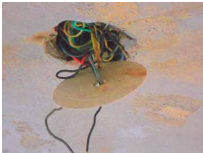
Ci-dessus et ci-dessous: Appartement en cours de travaux Photo Lucile Pierron BC-A
