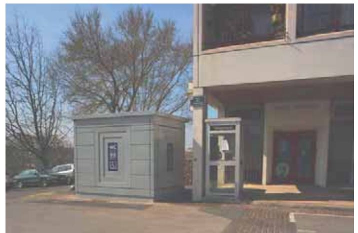
La problématique des déchets et de leur collecte marque fortement le projet d'aménagement du parvis.
