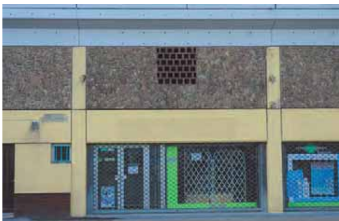
Les quelques commerces côté parking avant l'opération.
