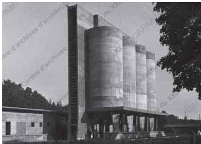
1949-1951. Usine d'ammoniac pour les Houillères du bassin de Lorraine, Carling (Moselle) : vue ext., n.d. (cliché anonyme). (Objet AILEM-B-49-4. Dossier 078 Ifa 2004/3. Doc. AR-19-11-10-14).
