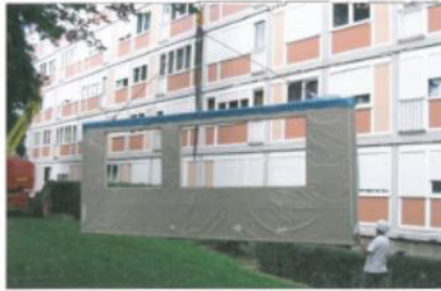
Mise en place des panneaux préfabriqués
