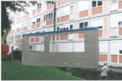
Mise en place des panneaux préfabriqués
