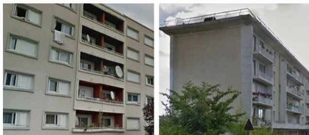
Fenêtres Loggias Mur Pignon Balcons
