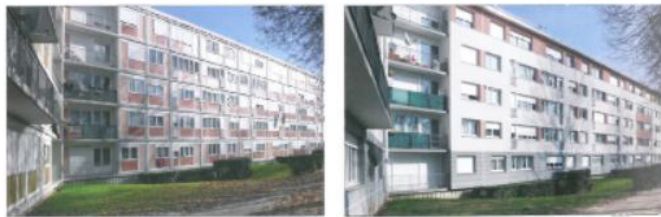
Façade des immeubles avant / après réhabilitation
