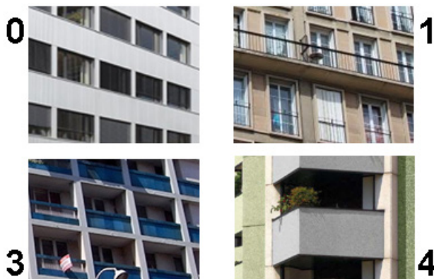
Figure 7.02 : Illustration du degré d'obstruction des percements de façades
