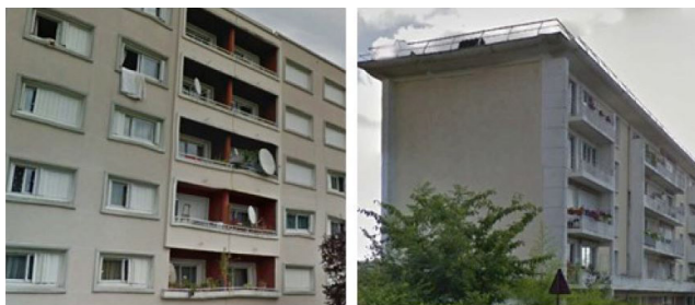
Fenêtres Loggias Mur Pignon Balcons
