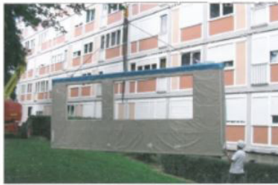
Mise en place des panneaux préfabriqués
