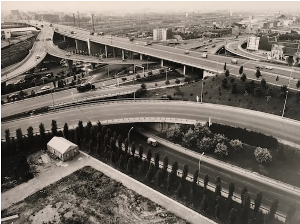
Figure 14 : Boulevard périphérique Nord, Porte de la Chapelle, non daté (début des années 1970), Cliché Jean-Claude Bollier
