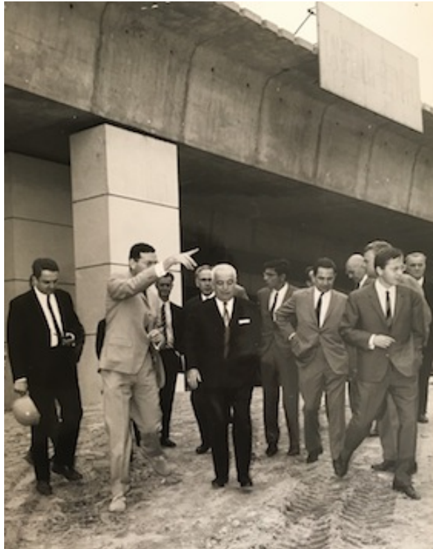
Figure 3 : Boulevard périphérique, Porte d'Ivry, Visite du chantier (on reconnaît au centre Maurice Doublet, en retrait à droite, André Herzog), 28 août 1968 Source Collection Pavillon de l' Arsenal
