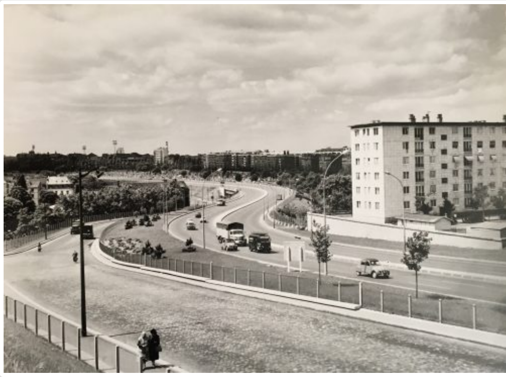
Figure 13 : Boulevard périphérique Sud, Poterne des peupliers, mai 1961, Cliché Jean-Claude Bollier. Source : Collection Pavillon de l'Arsenal.
