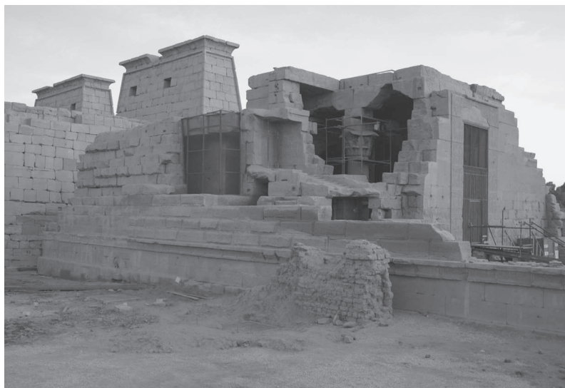
FIG. 21. – Les bossages de façade nord du temple d'Opet – C. Apffel / CFEETK.
