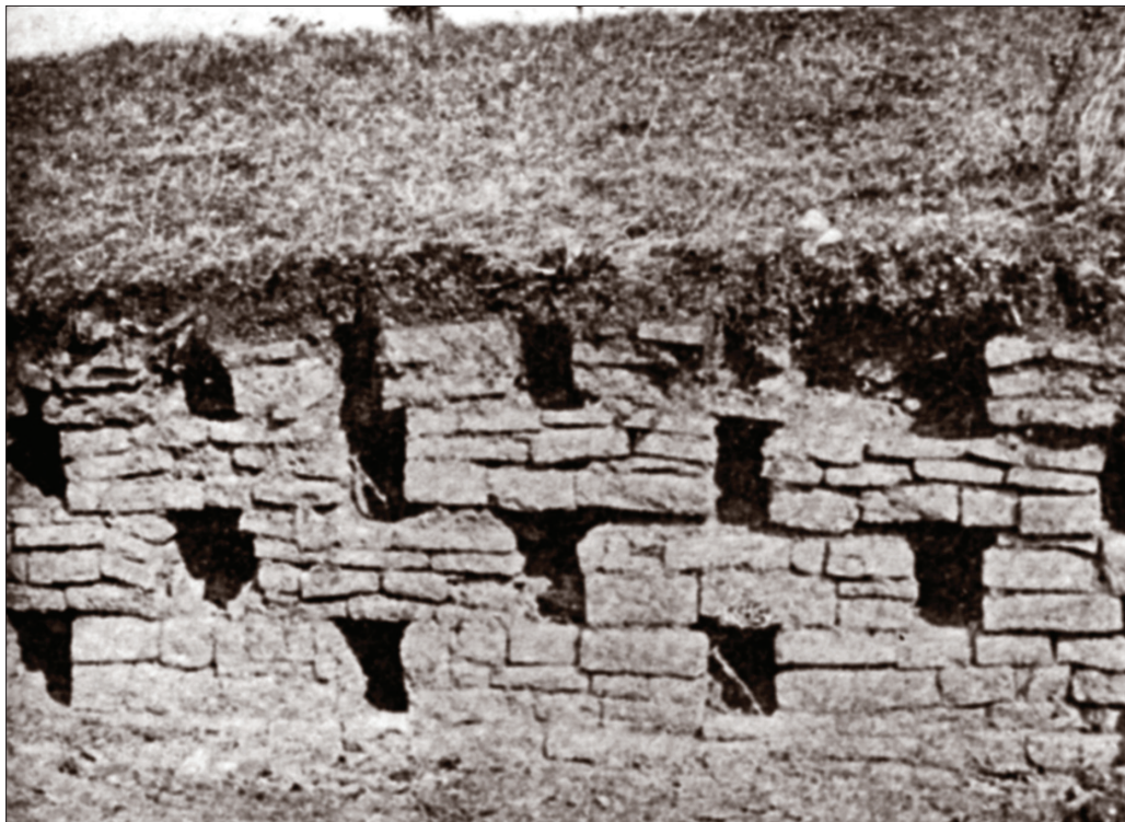
Fig. 4. Murus gallicus de l' oppidum de Vertault en Côte d'Or (d'après Déchelette 1914, p. 991, fig. 413).
