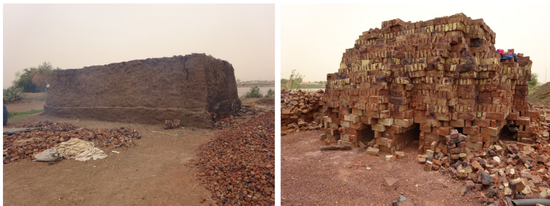
Figure 6. Four en activité après le colmatage et la mise à feu (à gauche) ; démontage progressif du four (à droite)
