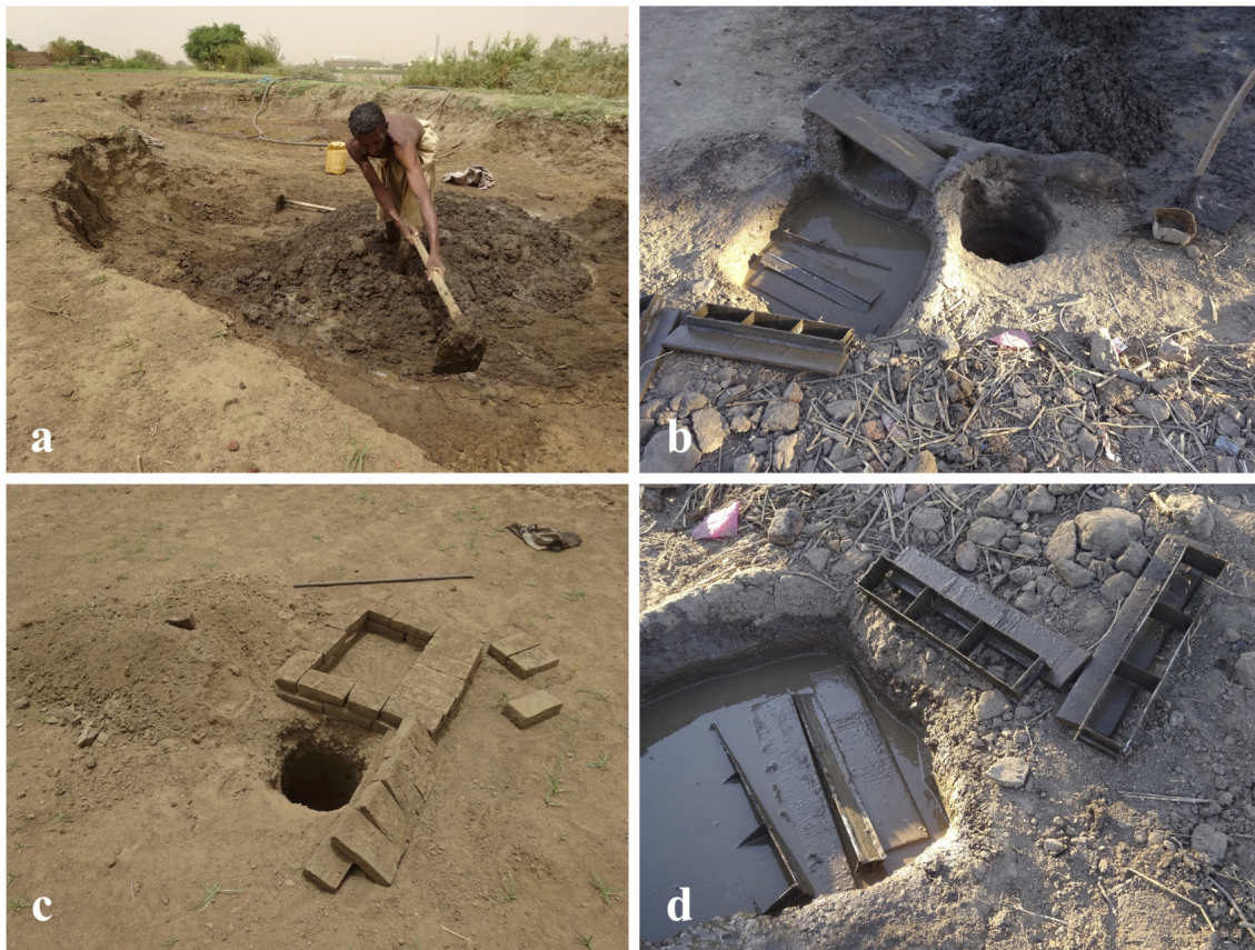
Figure 2. Processus de fabrication des briques
