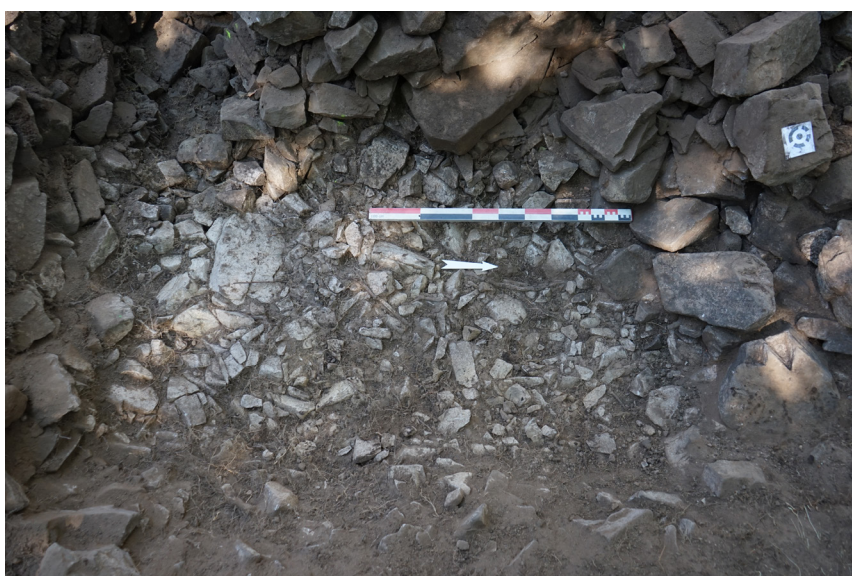
Fig. 63 : Semelle de fondation débordante de la structure 30.1 ?
