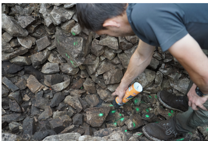
Fig. 48 : Marquage des pierres démontées
