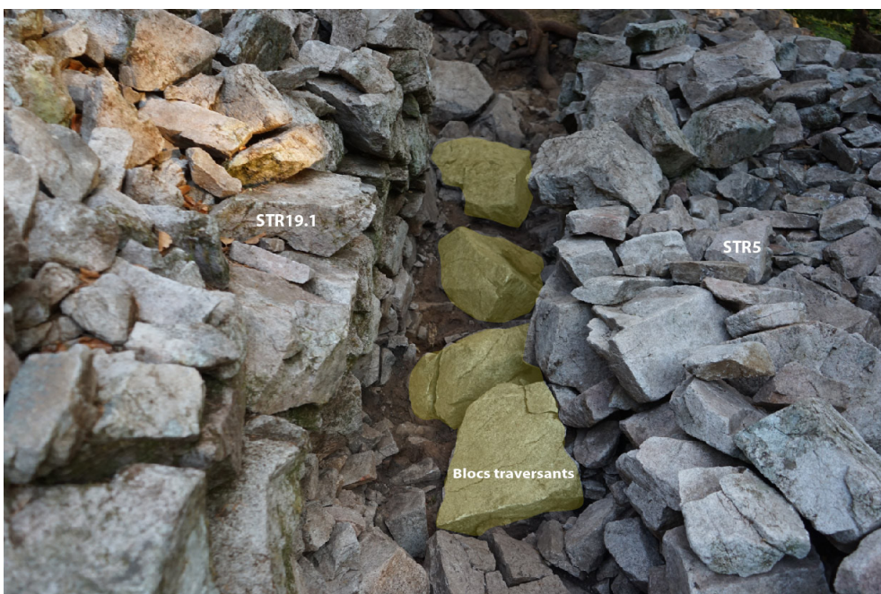
Fig 55 : Blocs traversants entre la structure 19.1 et 5
