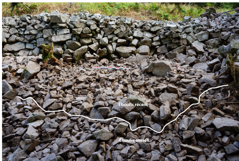
Fig 51 : Parement occidental de la structure 19.1
