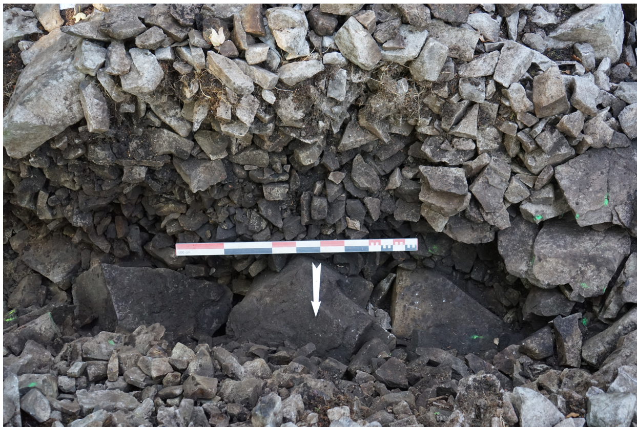
Fig. 66 : Boutisses parpaignes - structure 30.1
