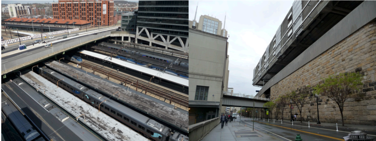
5. Les voies et ponts au nord de la gare ; F Street à l'est de la gare (Ruggeri, 2014)
