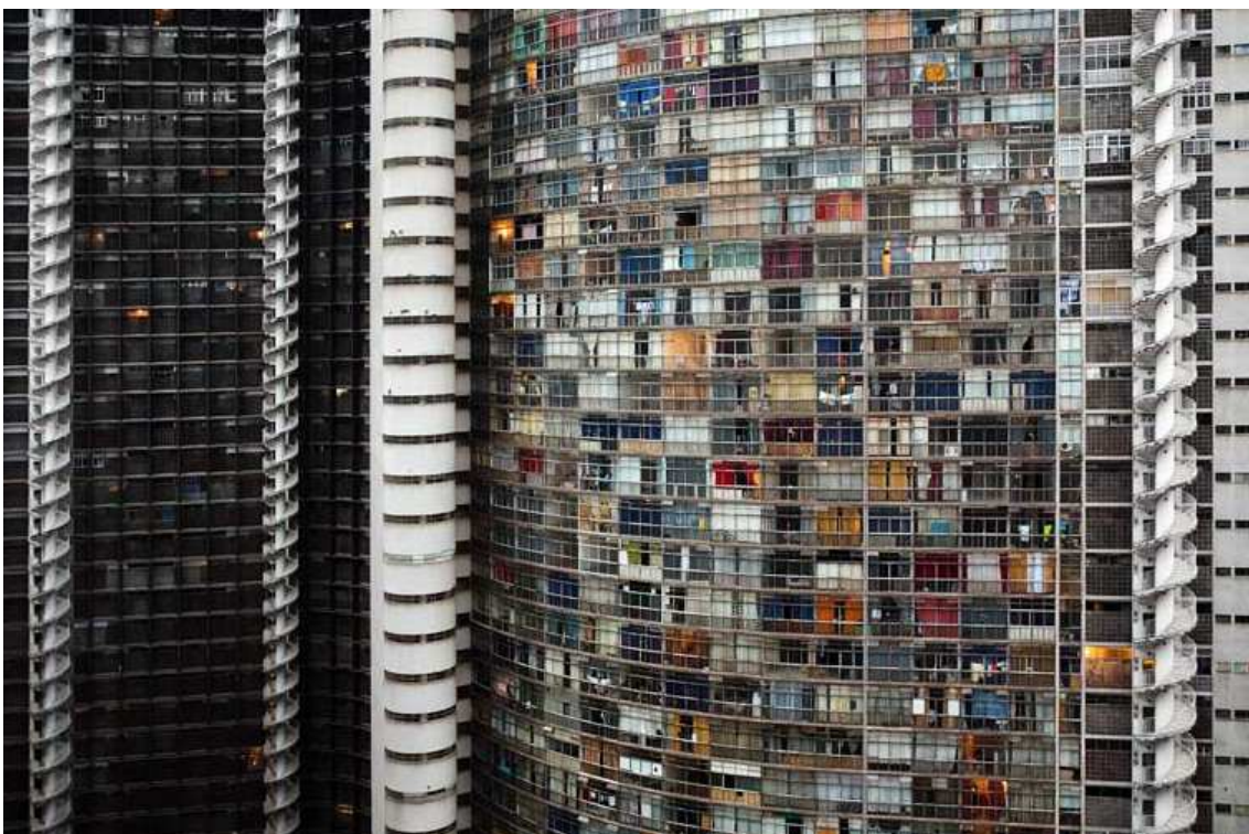
Photo 7 Immeuble du centre de São Paulo
