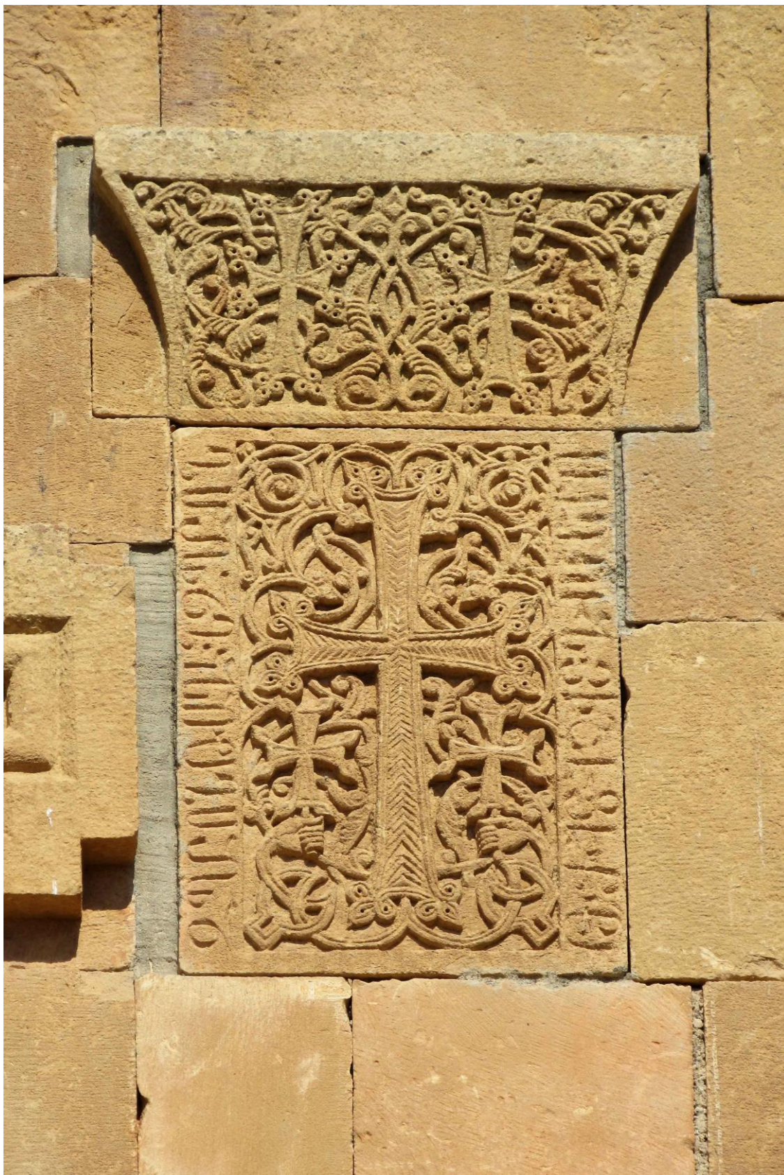
Fig. 17.9. Arménie (Rép. d'). Noravank'. Église funéraire de Burt'el Ōrbēlean (1331-1339). Façade ouest. Photo Patrick Donabédian
