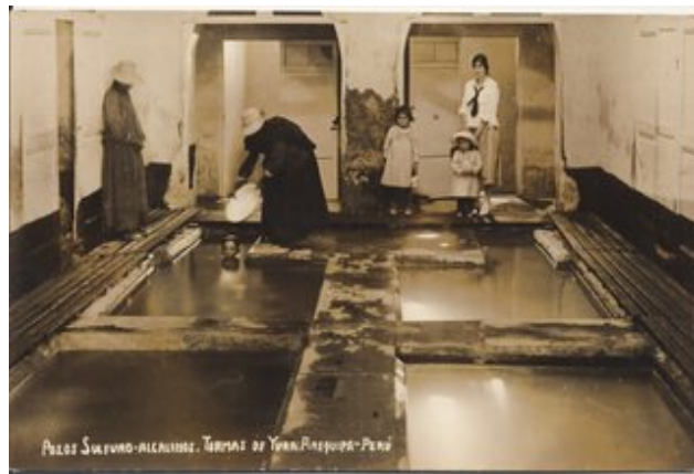
Fig. 11 “Pozos sulfuro-alkalinos. Termas de Yura Arequipa-Perú”, c. 1918
