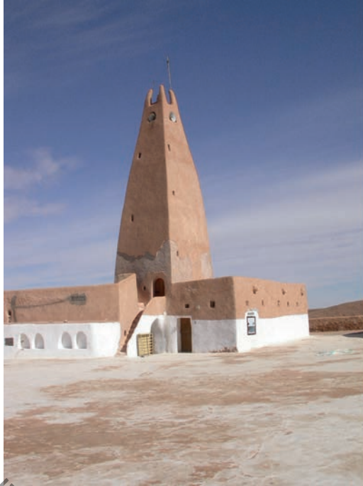
Fig. 6. Mosquée de Bou Noura (photo P. Cressier, 2010).
