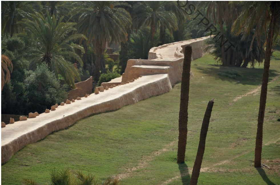
Fig. 17. Barrage "d'absorption" de Beni Isguen. En amont, le réservoir est aujourd'hui pratiquement comblé par les sédiments (photo Y. Montmessin, 2011).
