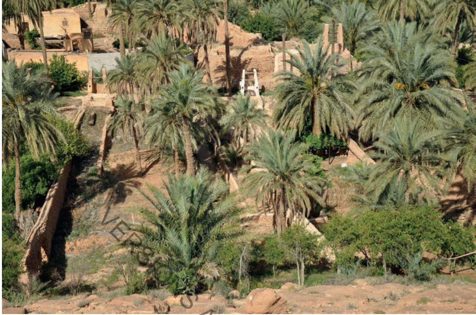
Fig. 16. Trois puits à traction animale sur rampe rectiligne de la vallée de Beni Isguen. Le puits situé à gauche de la photographie est abandonné, mais sa rampe est bien visible ainsi que le petit pont-aqueduc conduisant l'eau au lieu d'utilisation. Le puits situé au centre a été restauré et pourvu d'une moto-pompe (photo Y. Montmessin, 2011).
