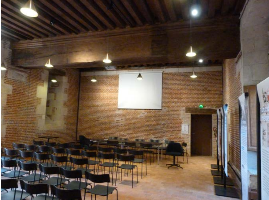
Fig. 5 : Poutre imposante supportant le solivage du plafond © Mélinda Bizri.
