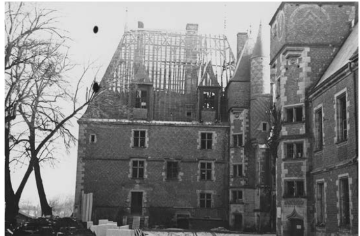
Fig. 21 : Vue de l'aile est après l'incendie de juin 1940 qui a ravagé la toiture suite au bombardement © Médiathèque de l'architecture et du patrimoine.
