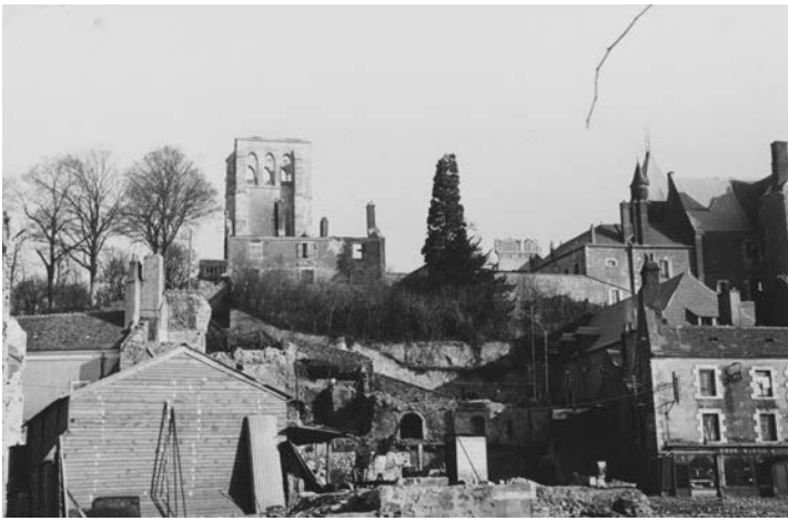
Fig. 18 : Vue de la terrasse du Belvédère Ouest après le bombardement de juin 1940 © Médiathèque de l'architecture et du patrimoine.
