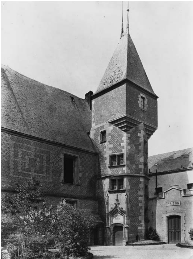
Fig. 2 : Entrée de la prison, vers 1892, Alfred-Nicolas Normand © Médiathèque de l'architecture et du patrimoine.
