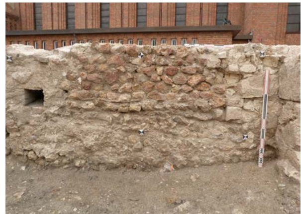
Fig. 4 : Fondation et partie d'une élévation du bâtiment quadrangulaire maçonné © Département du Loiret - SAP.
