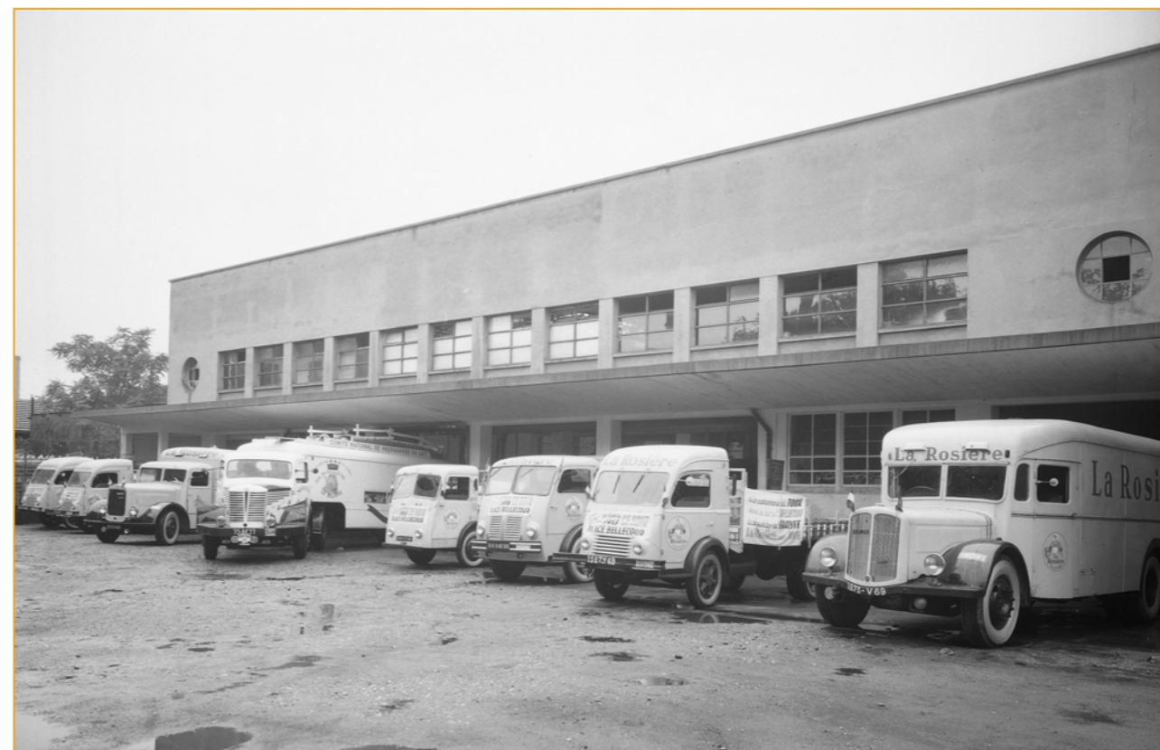
La coopérative laitière « La Rosière » dans les années 1950 (source : Archives Municipales de Lyon)
